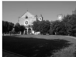
Chiavaralle (Ancona): l'abbazia cistercense
