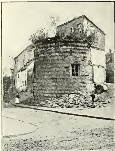
Fig. 92. Bonn. Ehemaliger Mauerturm der Nordseite.
