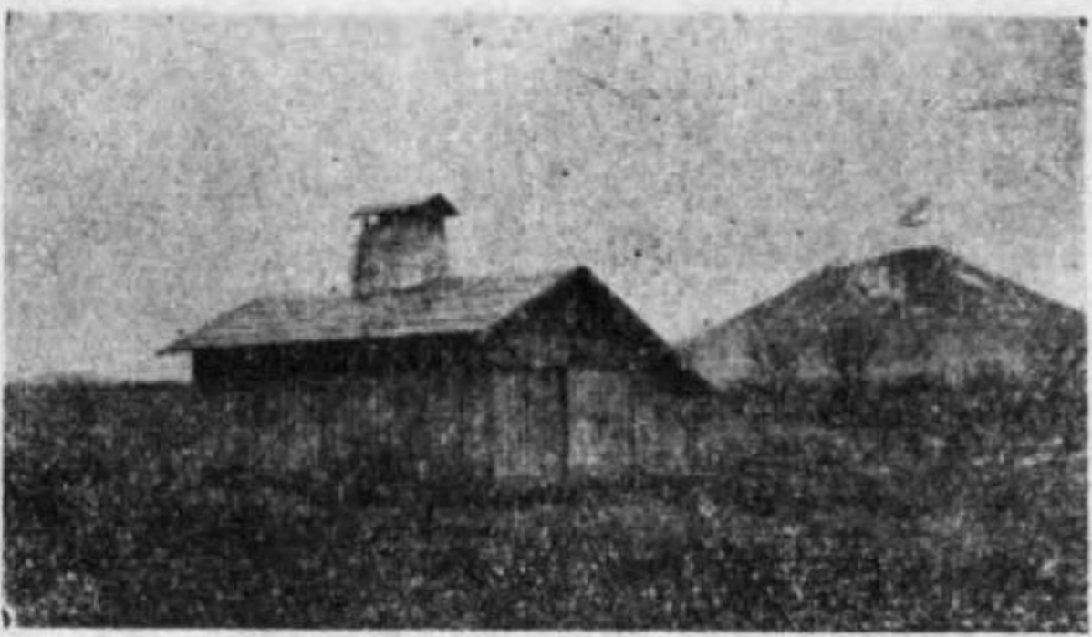
岩手縣岩手郡松尾村に建設された馬糶場
