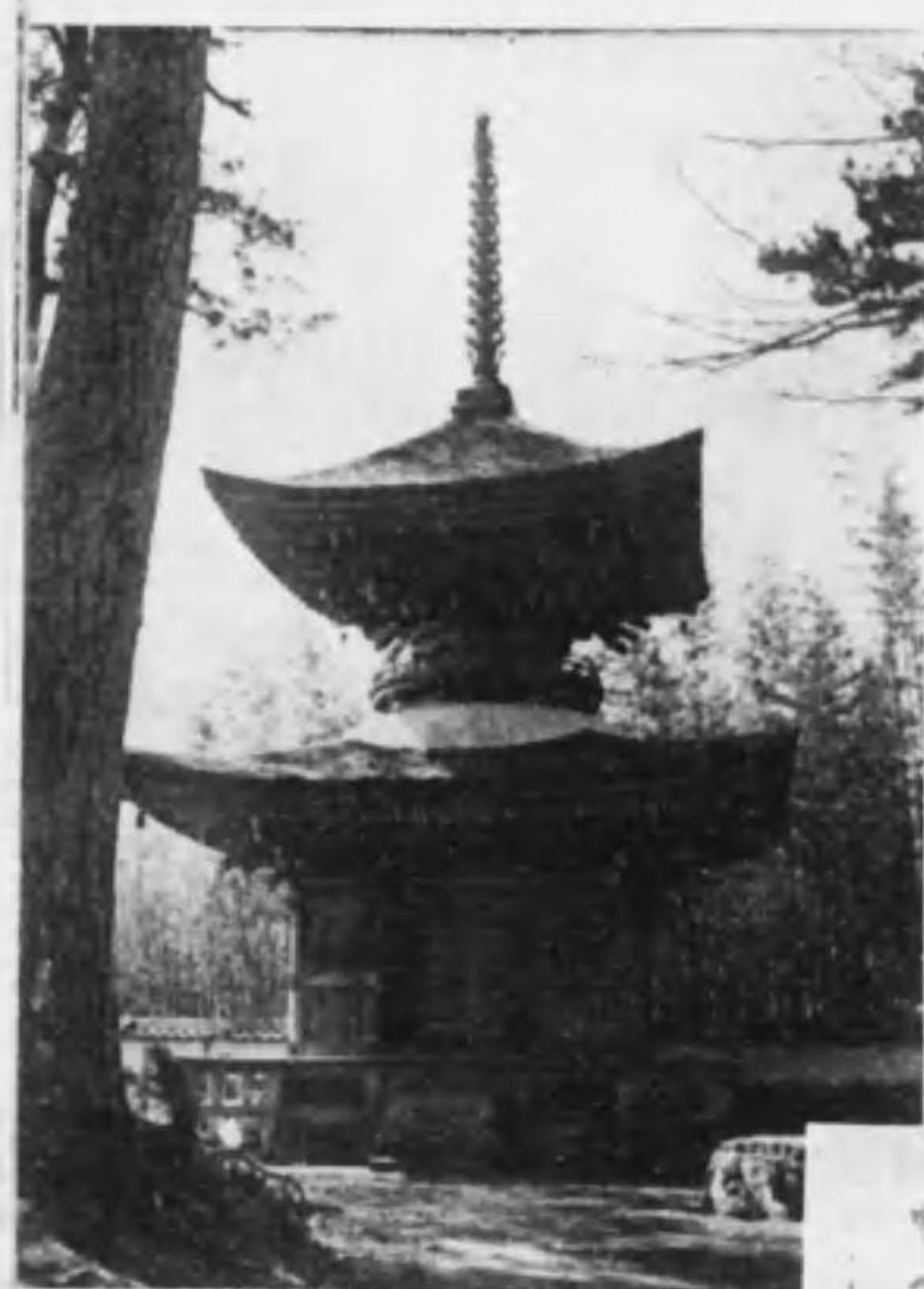
大樹寺多寶塔(岡崎市)
