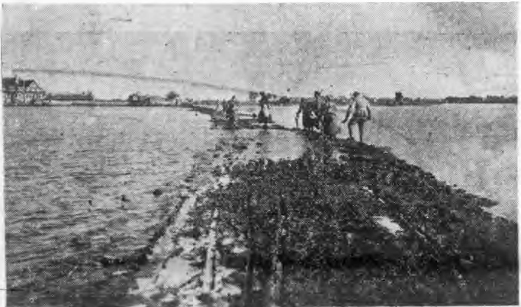
大落水之後三育村一條用灰塊墊之高路通德縣街市 ○路旁積水，尚有數尺深，足見水情之一班
