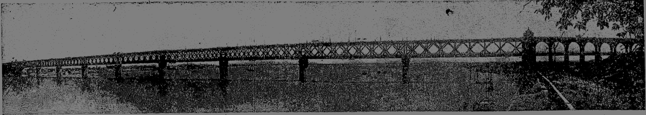
↑ 武漢長江大橋全景。
