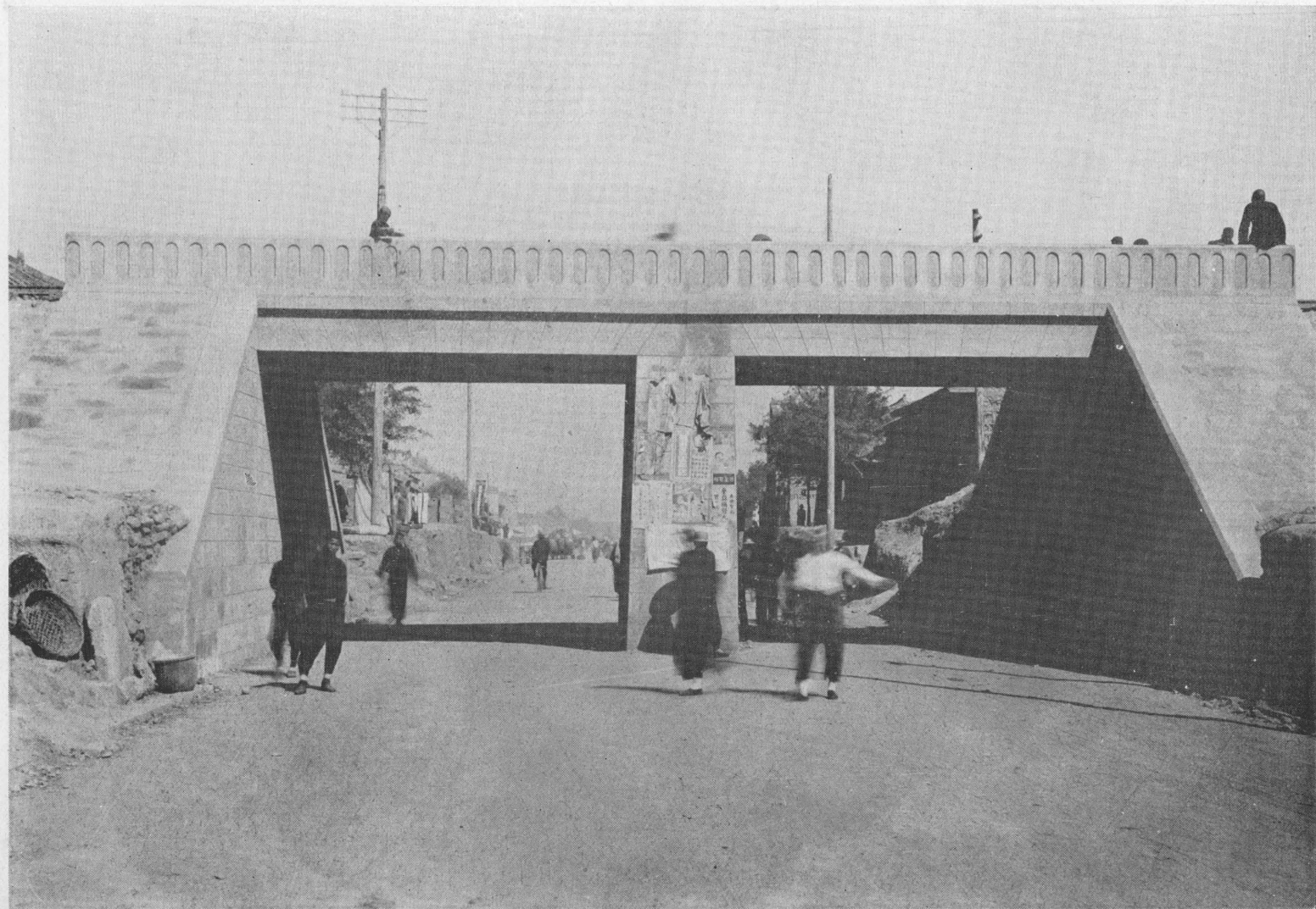
長安北關雙孔鐵路懸橋
