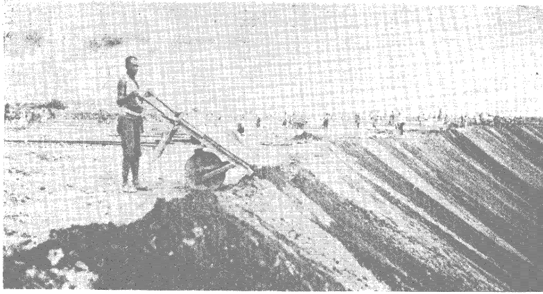
西寶雞站內土方工程
