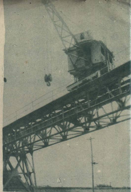
芬雅察碼頭之五噸起重機專作火車上裝卸貨物
