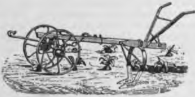
1. Свеклокопатель съ лемехами.
