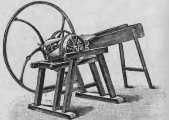
7. Передача помощью сложной конической шестерни въ соломорѣзкѣ Морица.
