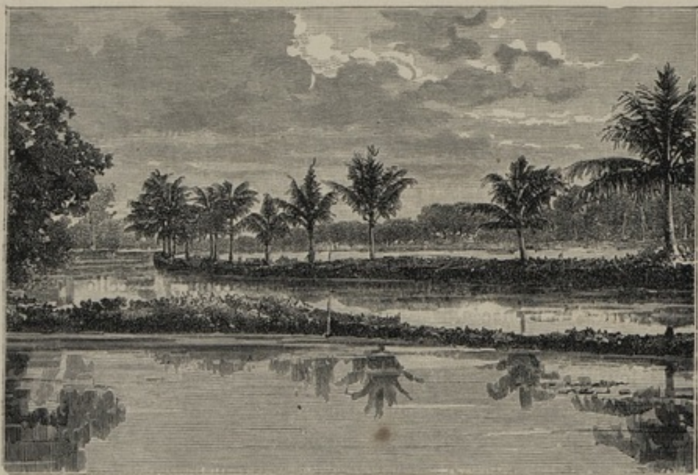
UNE DIGUE DANS LES RIZIÈRES.
