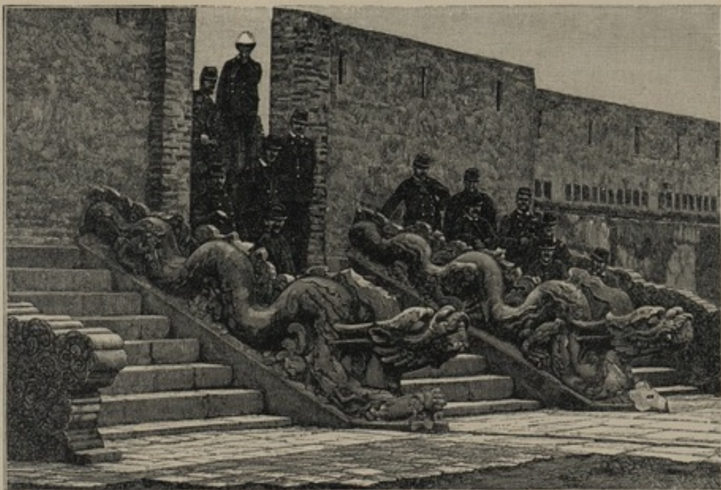
CITADELLE DE HANOÏ. — ESCALIER MONUMENTAL.
