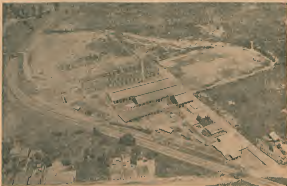
Vista tomada pelos fundos das instalações da "Indústria Metalúrgica N. S. Aparecida", vendo-se o desvio da estrada de ferro que a serve. Do grandioso conjunto, percebe-se uma parte, das instalações, ainda em construção.
