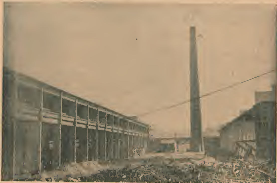
Um aspecto dos pavilhões recentemente construídos
