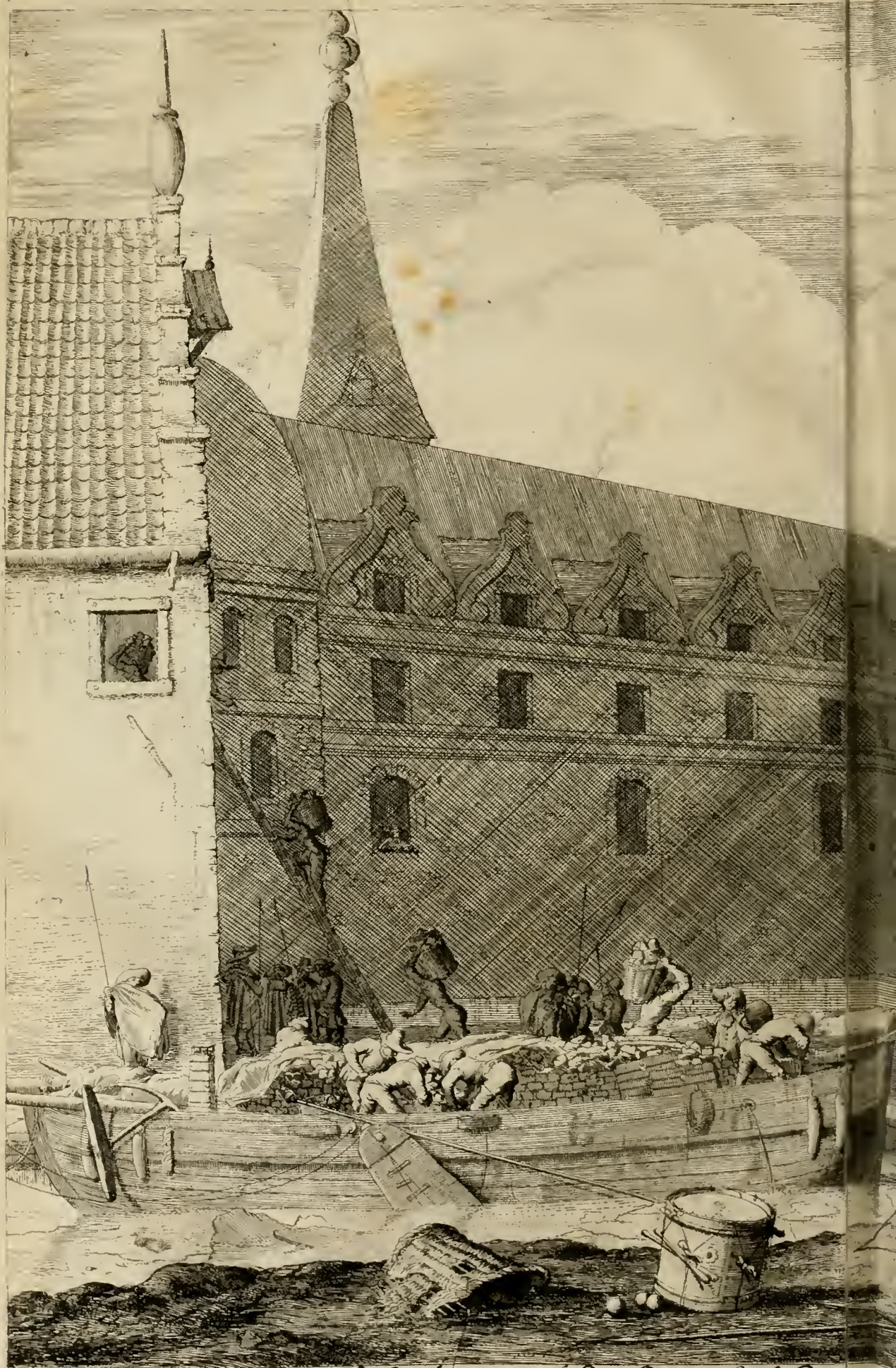
Het Kasteel van Breda door Soldaaten,
