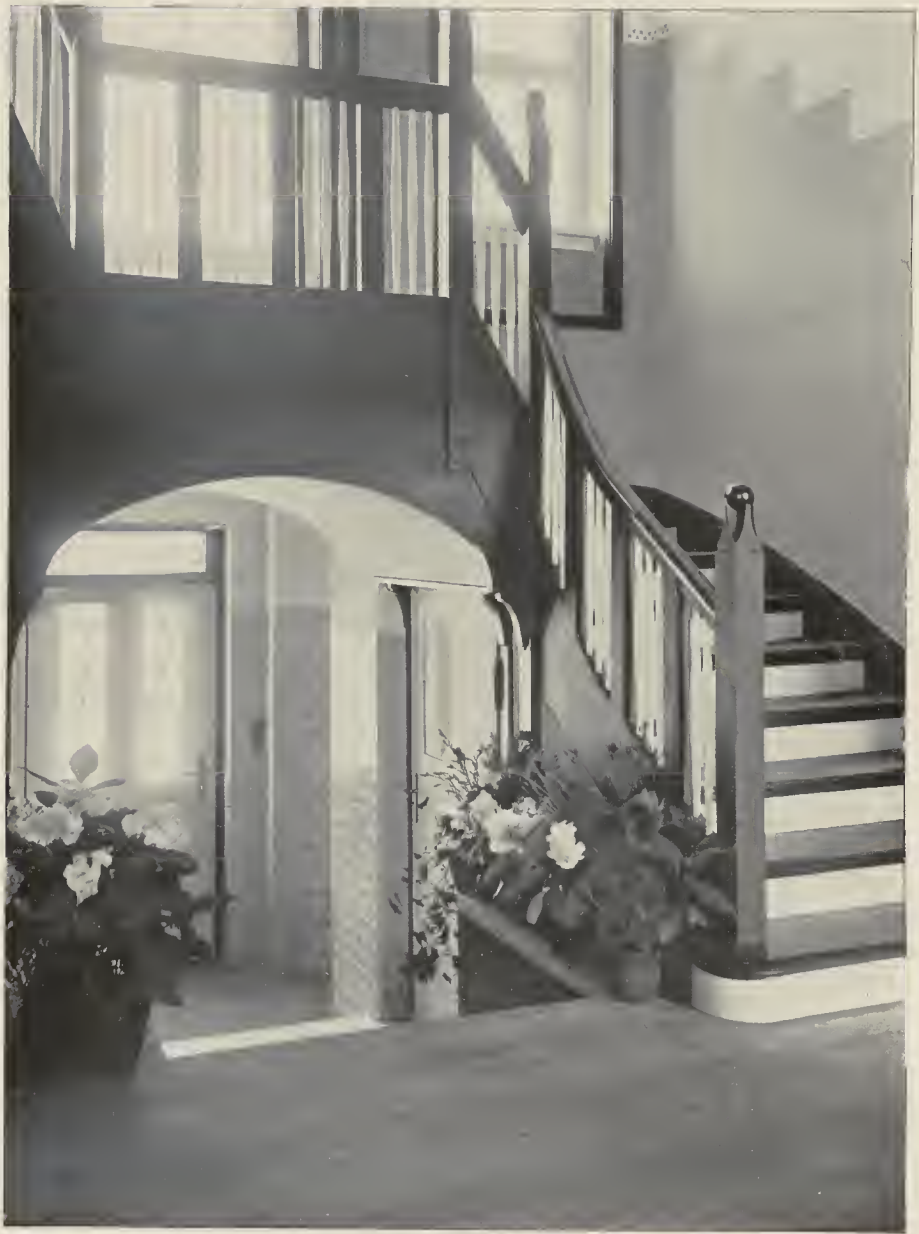
F. W. JOCHEM-KIEL Haus Völkert: Treppenhalle
