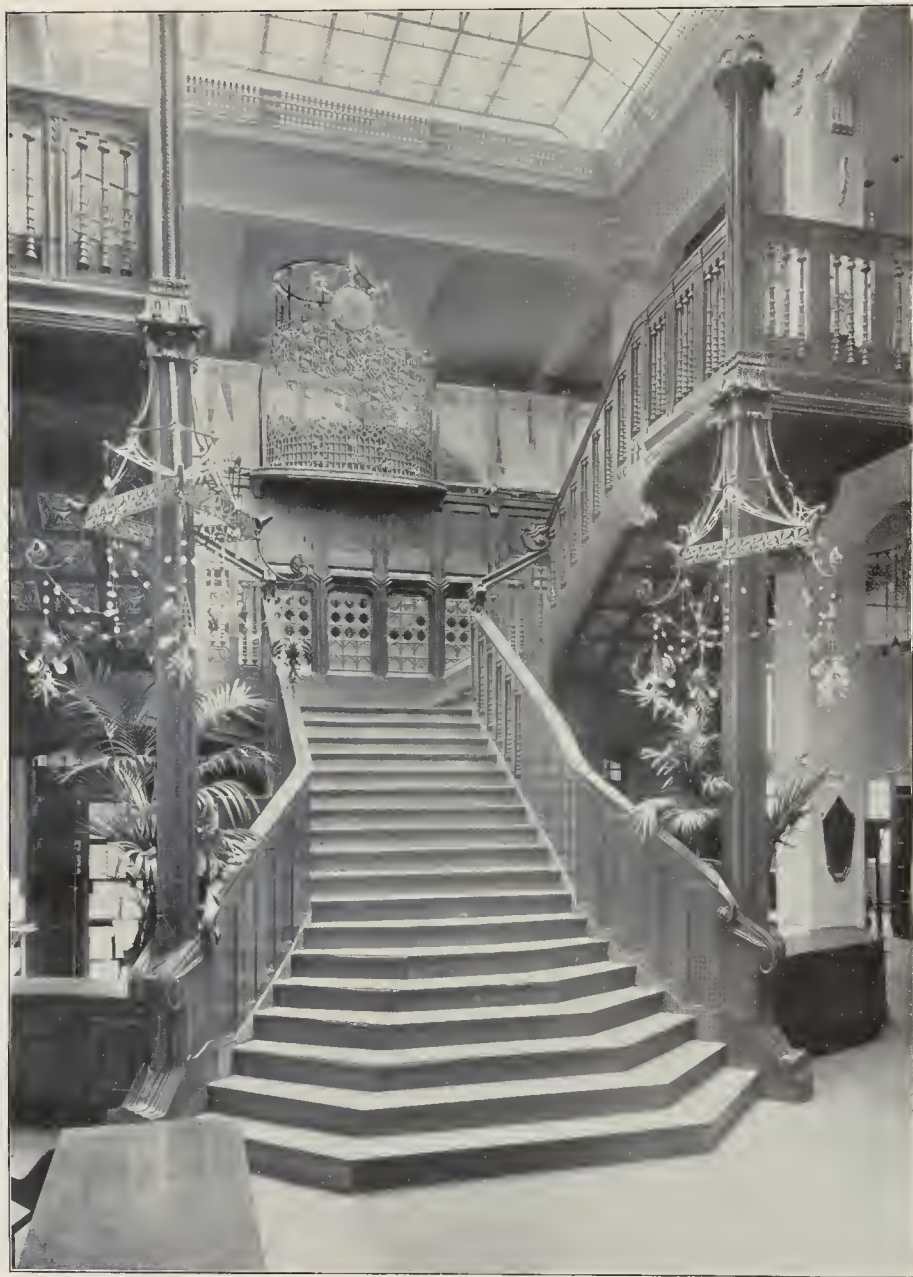
ARCHITEKT MARTIN DÜLFER-DRESDEN Kaufhaus M. Schneider, Wiesbaden: Geschäftstreppe im Lichthof, Hauptansicht
