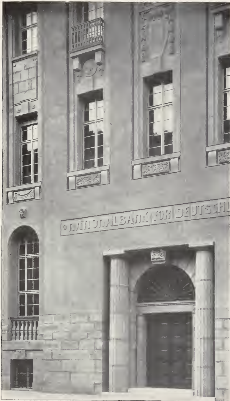
PROF. ALFRED MESSEL-BERLIN Neubau der „Nationalbank für Deutschland“ in Berlin: Teil der Fassade
