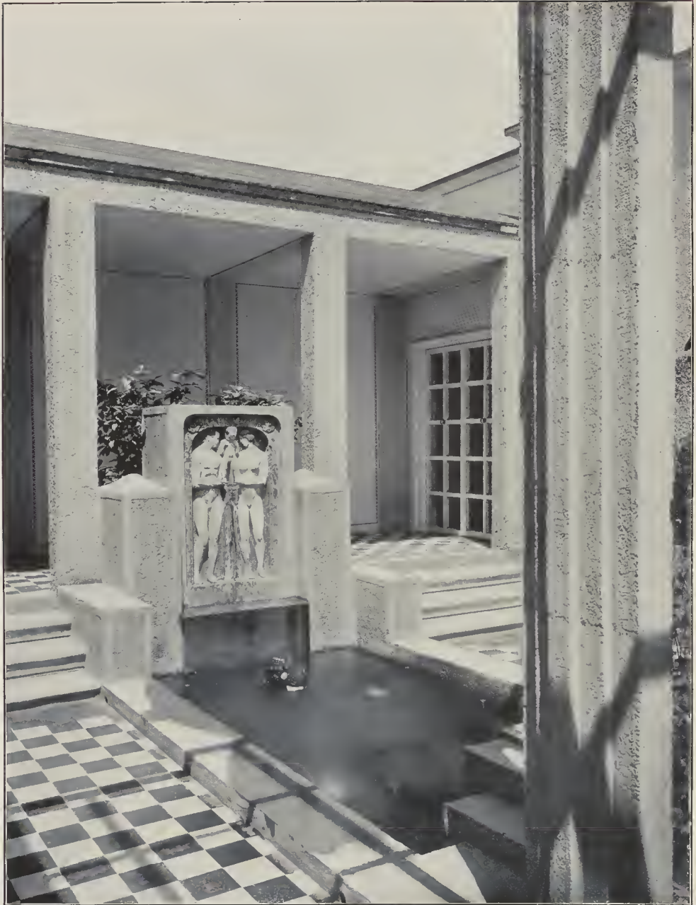
EMIL HOPPE-WIEN „Kunstschau“ Kleiner Hof in Beton-Architektur Brunnenrelief von KARL WILFERT-BUBENTSCH bei PRAG
