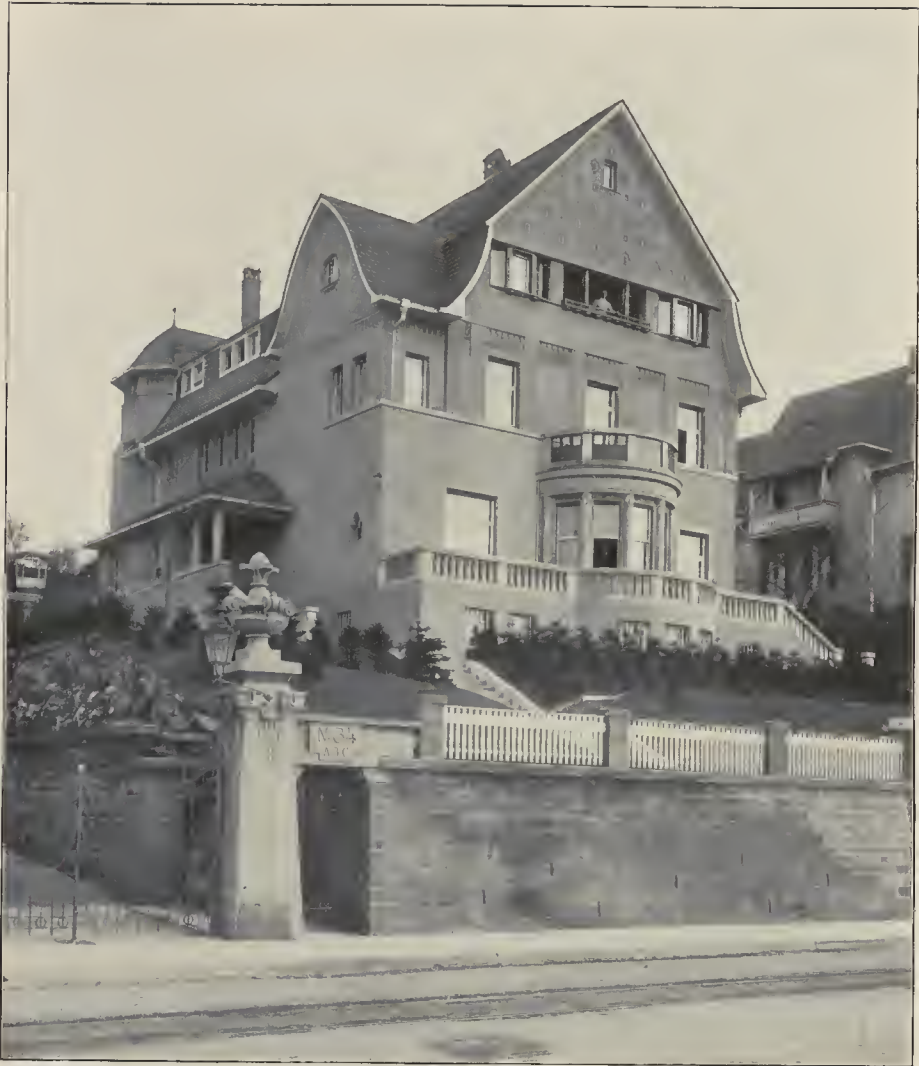
ALBERT EITEL-STUTTART Wohnhaus am Kanonenweg in Stuttgart
