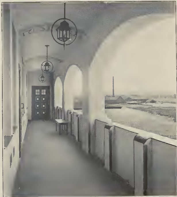
ARCHITEKT HANS ERLWEIN-DRESDEN 8. Bezirks-Feuerwache: Wasch- und Baderaum und Loggia vor dem Mannschaftsschlafsaal
