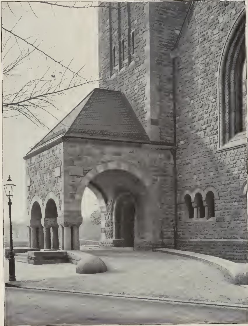
CURJEL & MOSER-KARLSRUHE Lutherkirche: Anfahrtshalle
