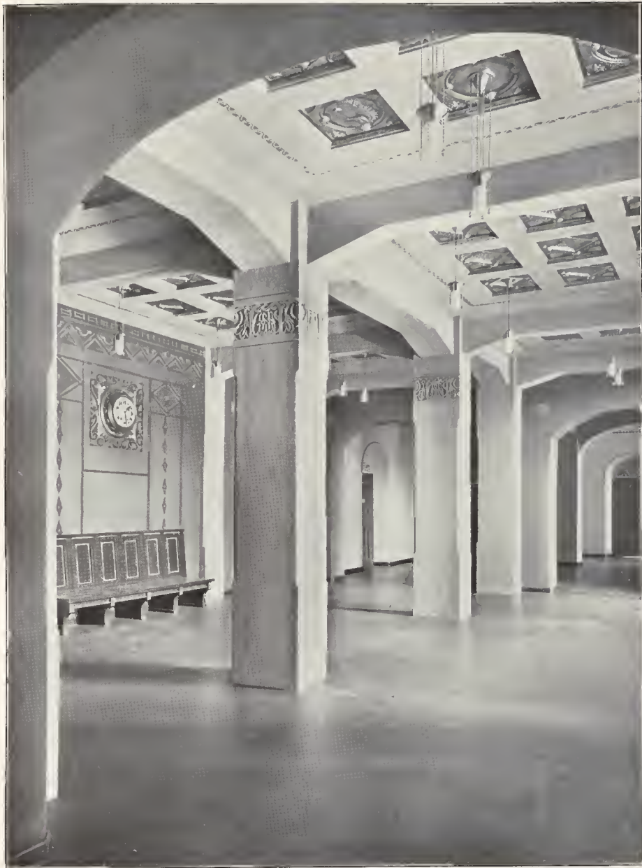
ARCHITEKT HANS ERLWEIN-DRESDEN König-Georg-Gymnasium: Treppenflurhalle im 1. Obergeschoß
