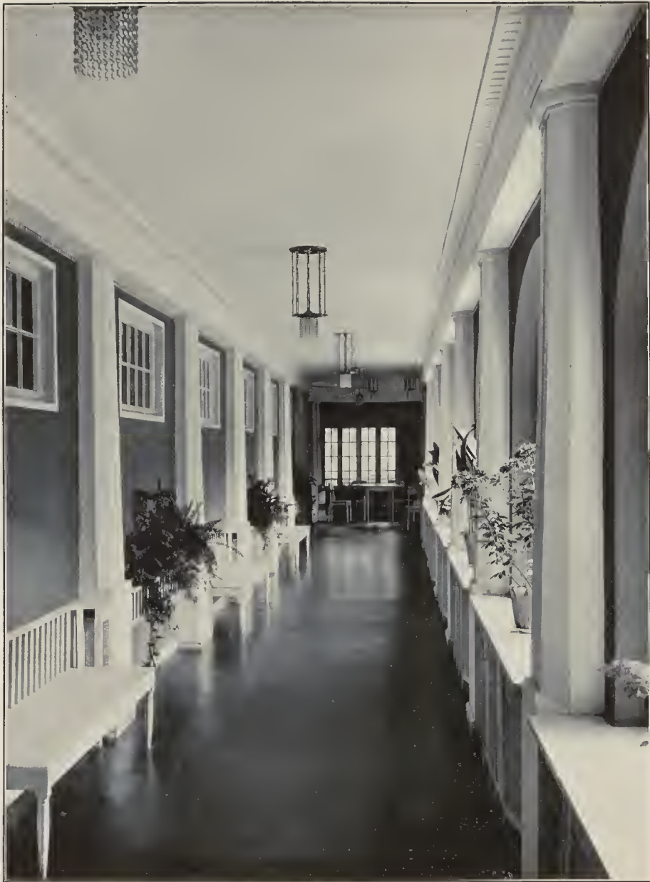
ALBERT GESSNER-CHARLOTTENBURG Kurhaus Dr. Warda: Wandelhalle
