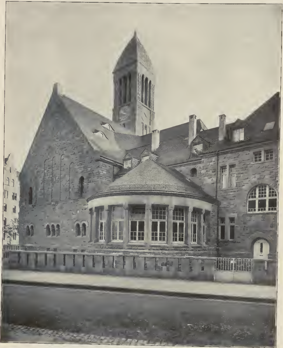
CURJEL & MOSER-KARLSRUHE Lutherkirche: Rückansicht mit Gemeinde- und Konfirmandensaal
