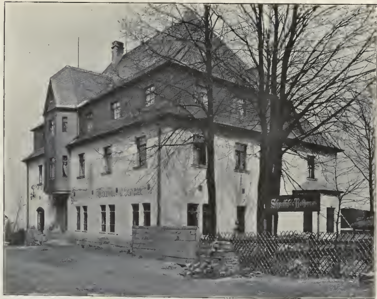
ARCHITEKT ALEXANDER HOHRATH-DRESDEN Gasthaus „zur Tanne“, Grünbad i. V.
