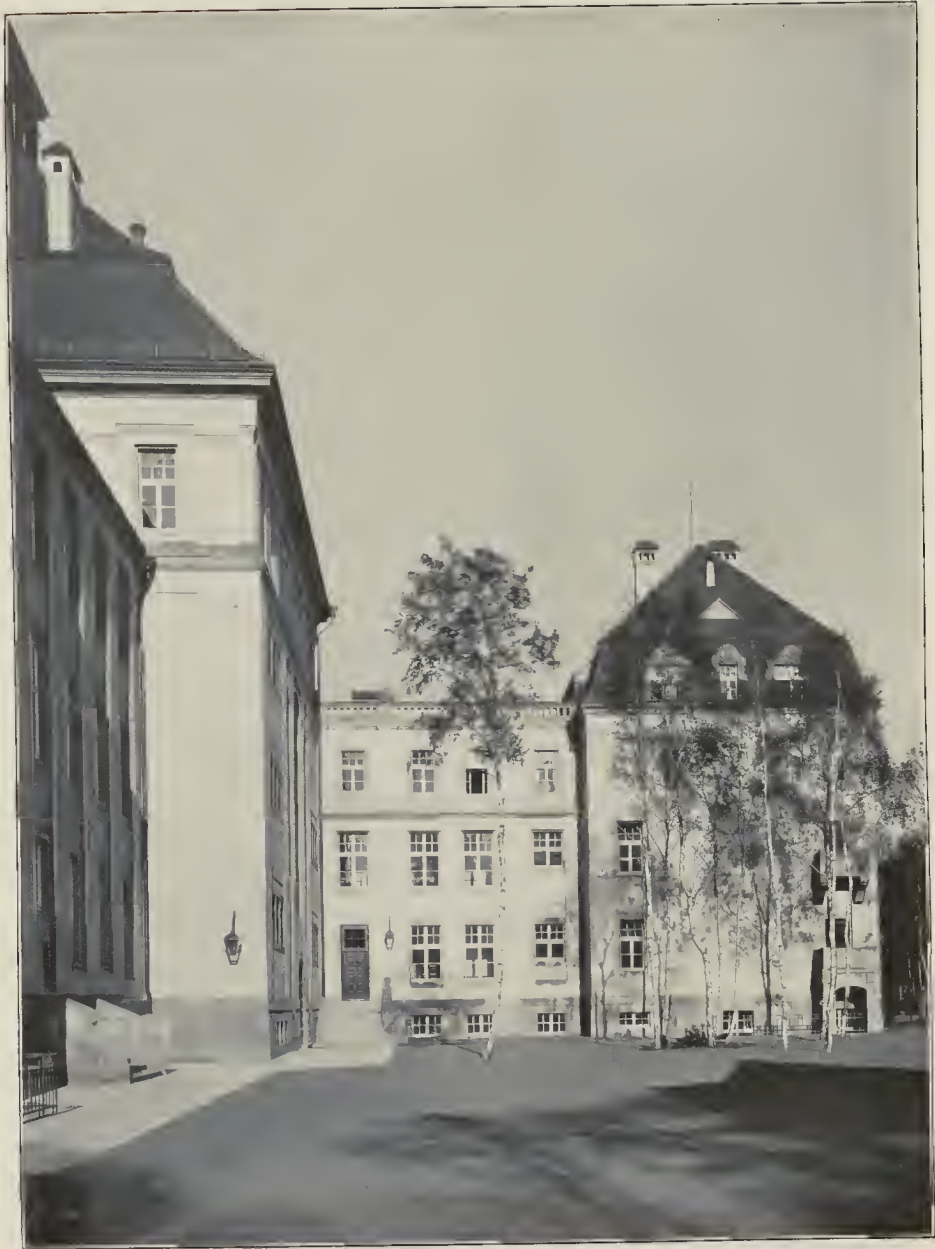
ARCHITEKT HANS ERLWEIN-DRESDEN König-Georg-Gymnasium: Hofansicht
