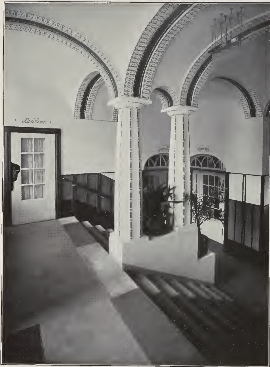
ALBERT GESSNER-CHARLOTTENBURG Kurhaus Dr. Warda: Eingangshalle
