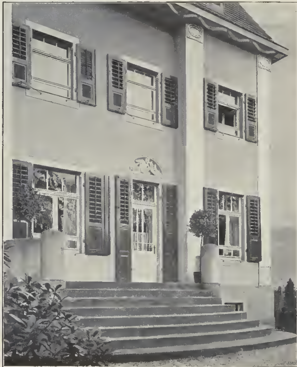
ARCHITEKT ERICH KLEINHEMPEL-DRESDEN Haus Springer, Dresden-A: Zwei Gartenansichten
