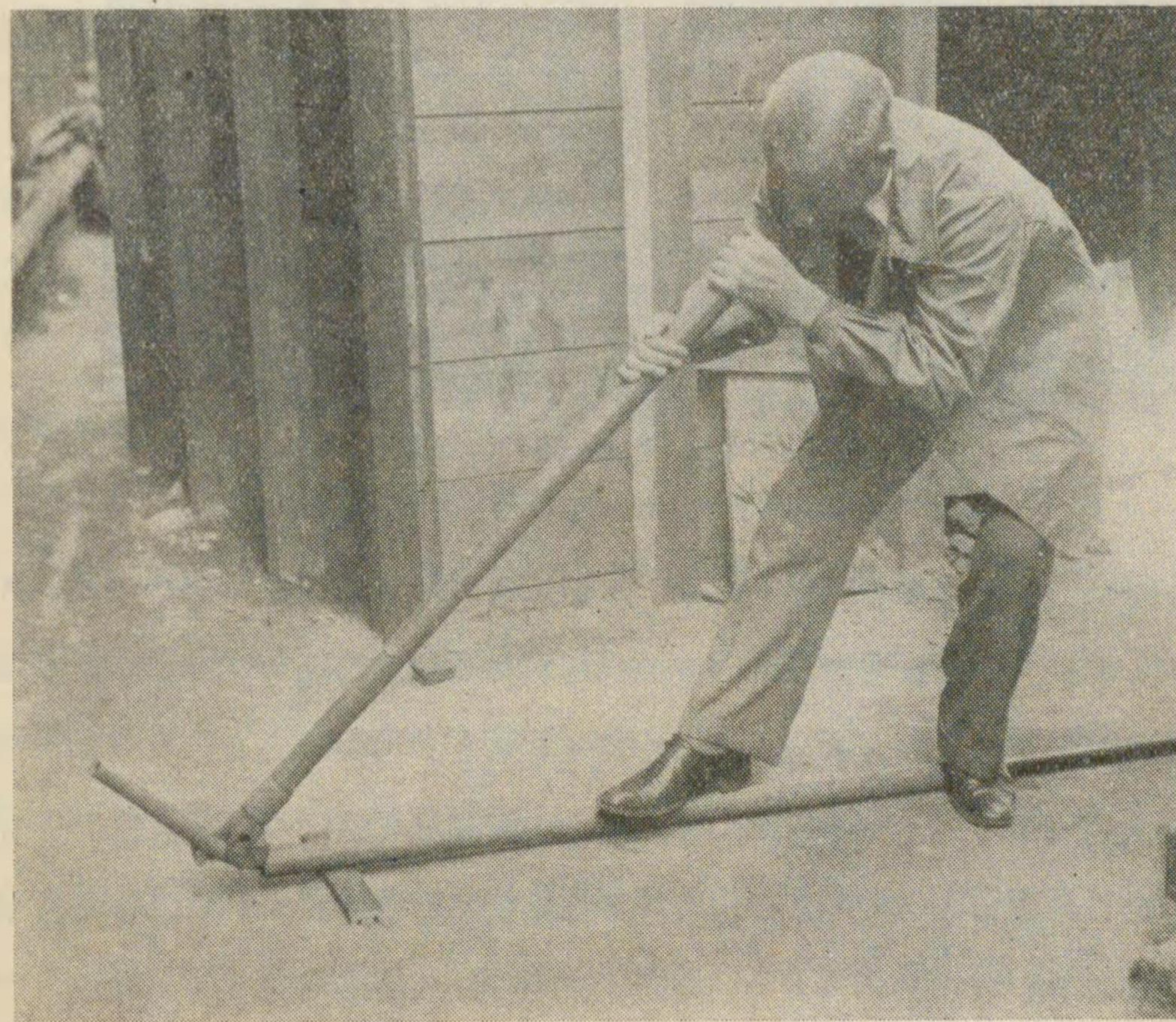
金属管をベンダーで曲げる有様
