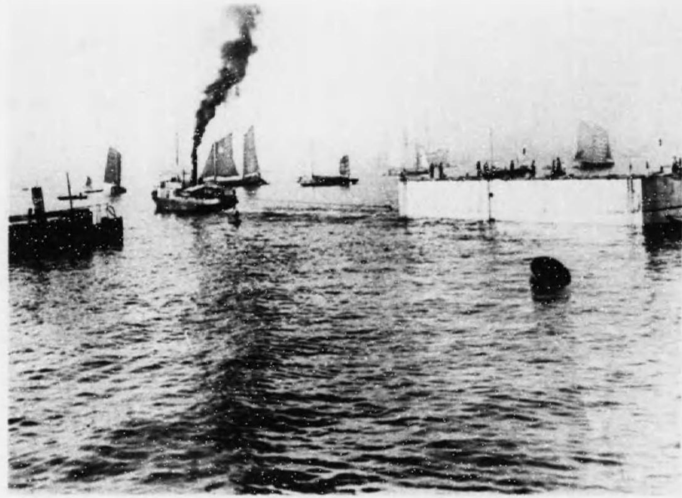
函土凝混筋鐵の中航曳へ場現
