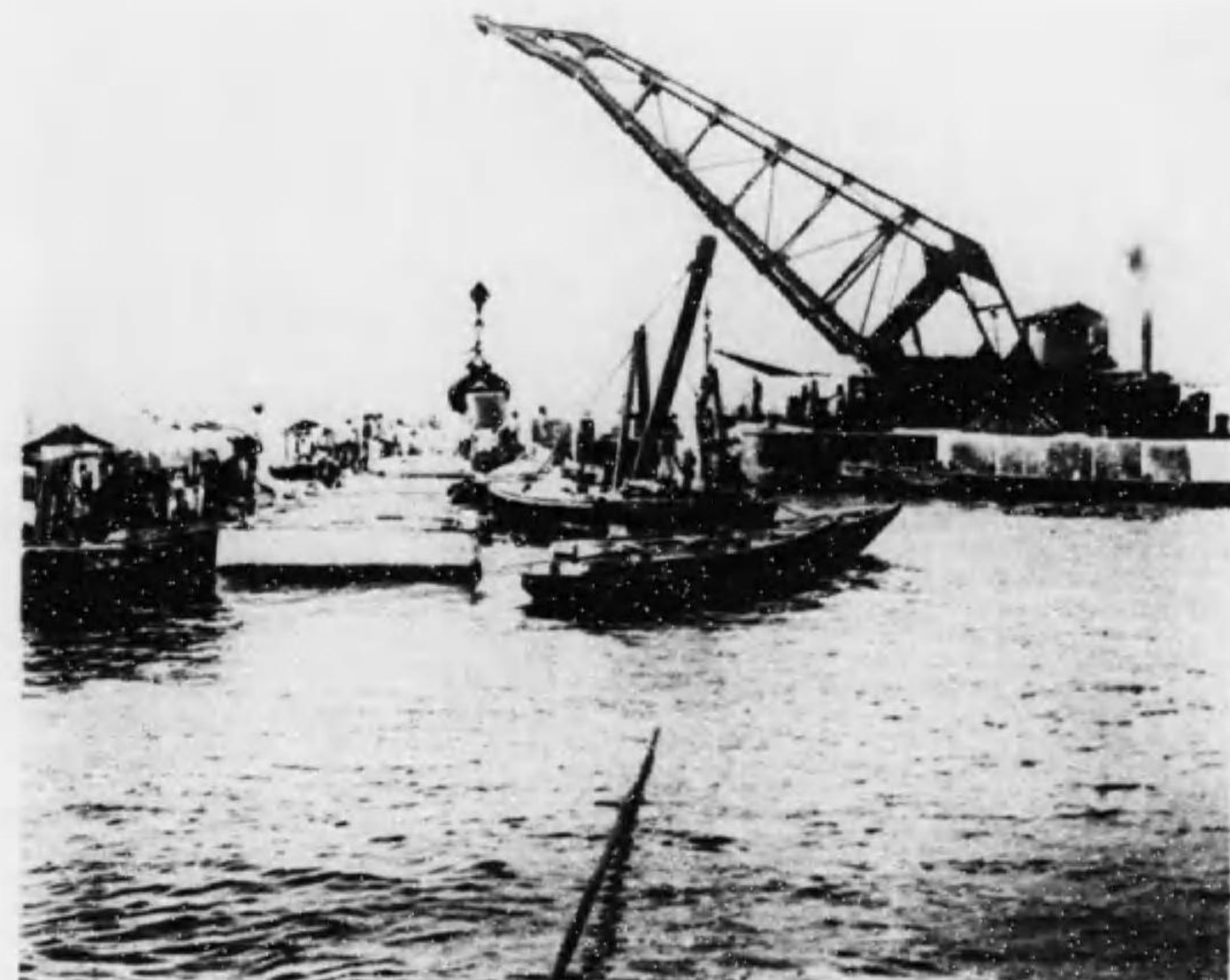
築造中の防波堤
