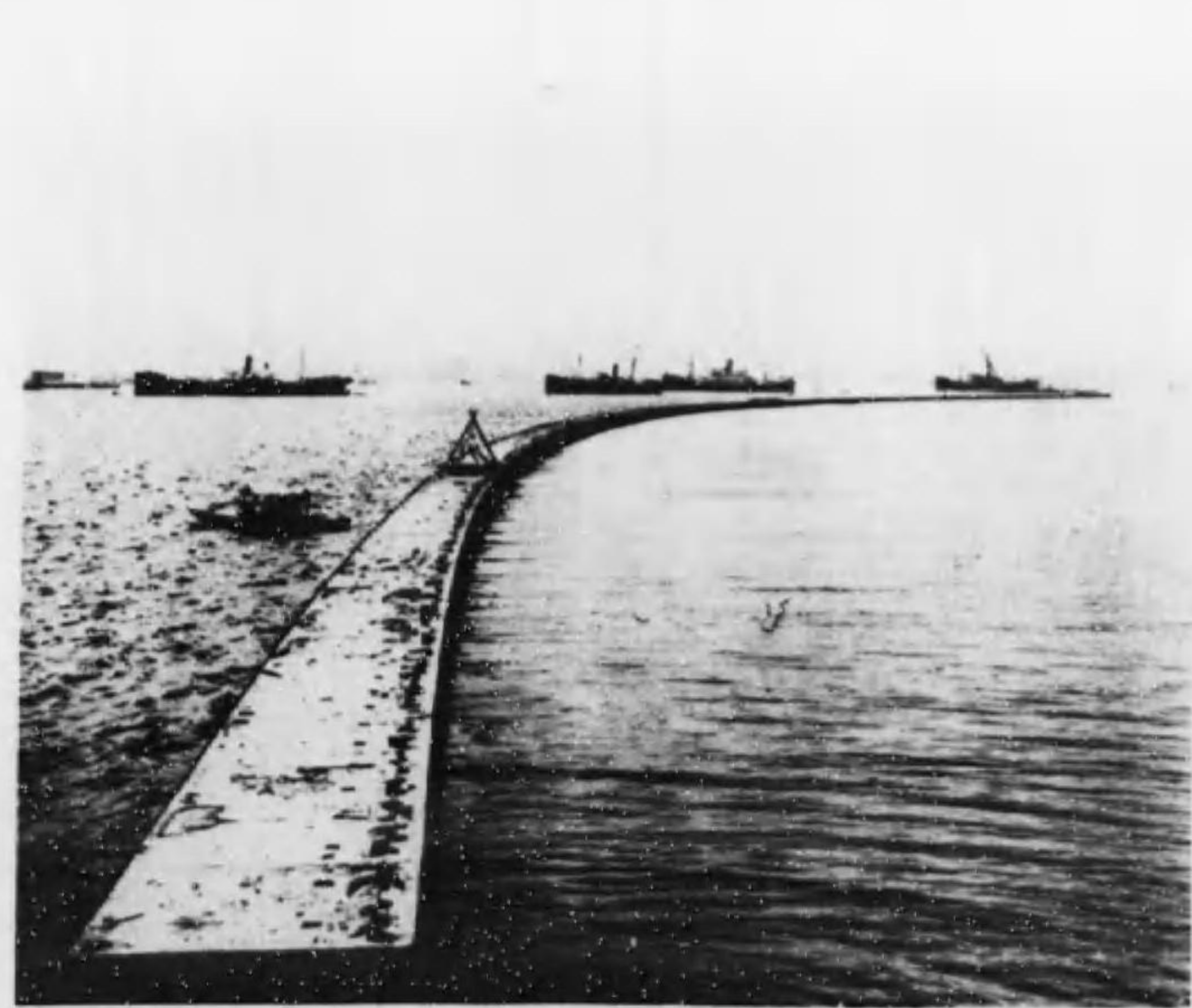
堤波防東の中造築
