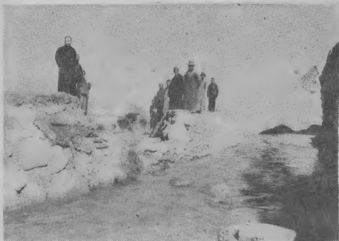
竣工理整壩頭左河渠金威武(上)
