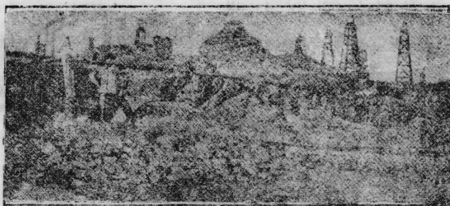
圖 91. 魯意西安那地方，用壓榨空氣從深井中壓上液體之硫。
