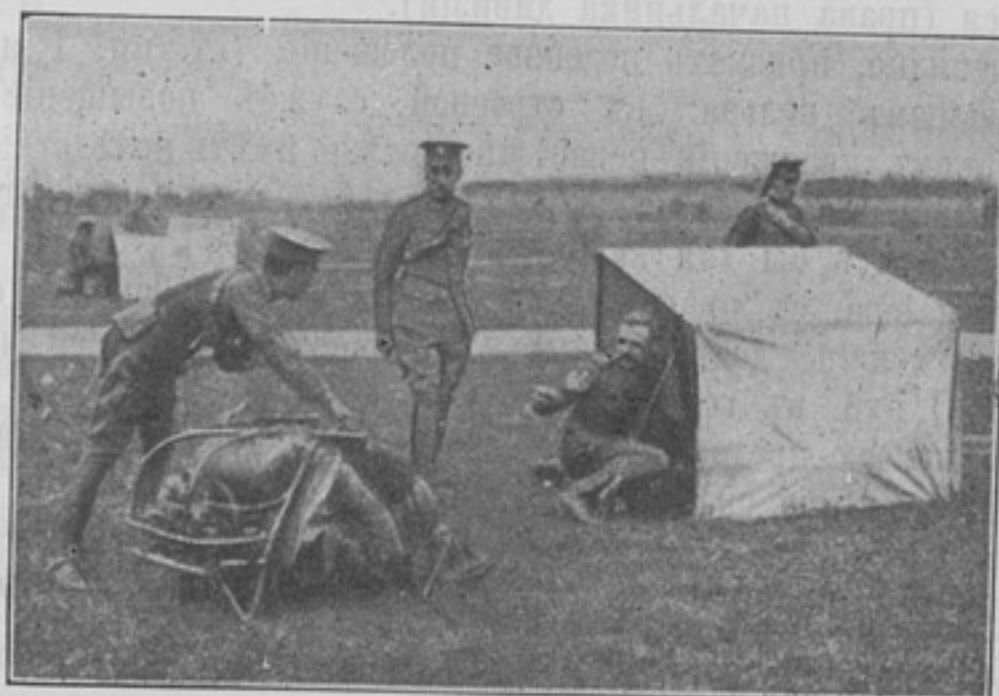
Беспроволочный телеграфъ въ англійской арміи. Переносный аппаратъ, приспособленный для перевозки на сѣдлѣ.
