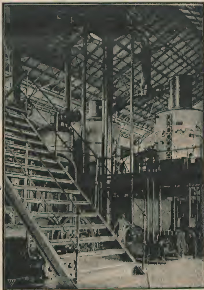
Fig. 19—Vista interna da usina «São José»
