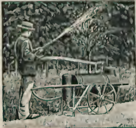
Bomba para pulverização e incendio
