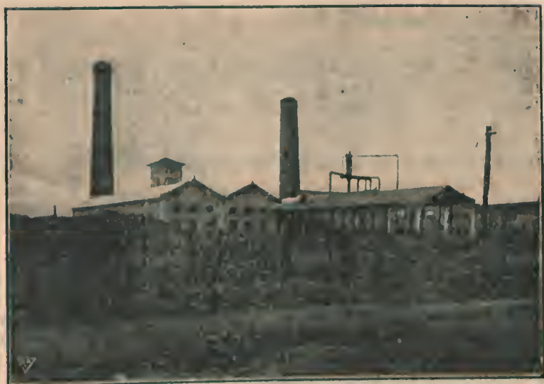
Fig. 13 — Usina «São João»
