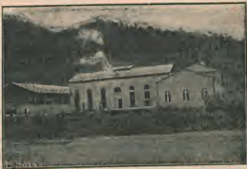
Fig. 22—Usina «Conceição Macabú»
