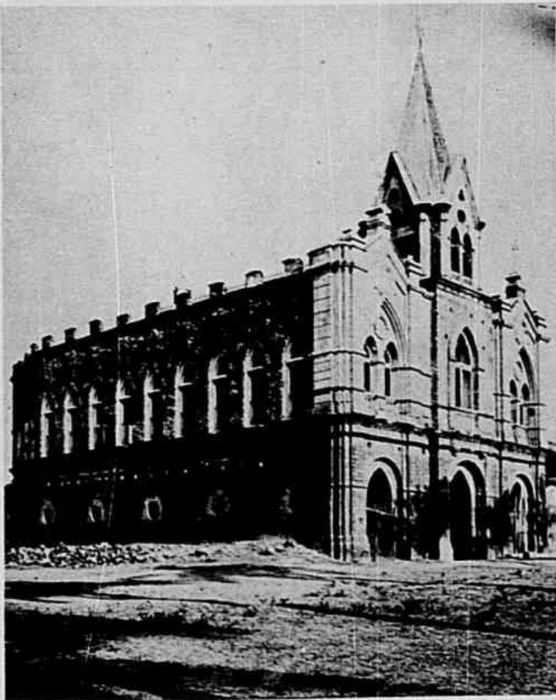
CAPELA DOS REMEDIOS
