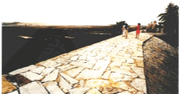
百城海堤 Sea Wall of Baicji
