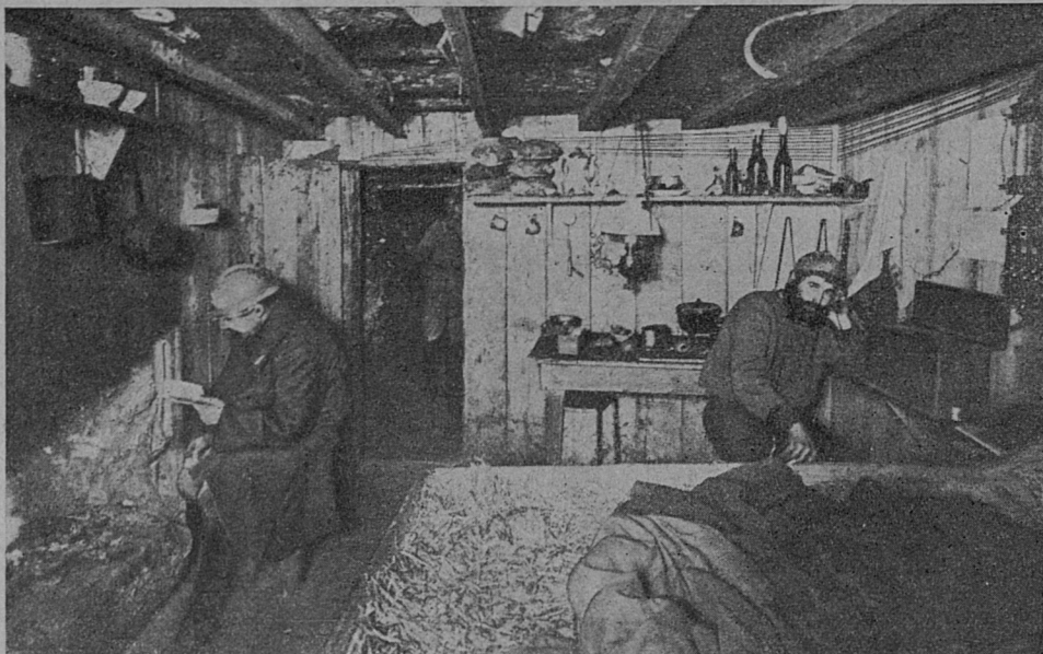
Подземная телефонная станція.
