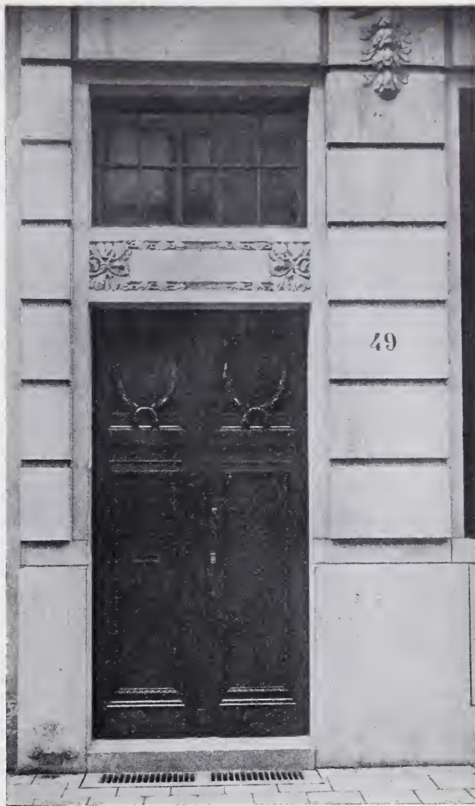
DETAIL VAN HET WOONHUIS TE ANTWERPEN. Arch. J. DE LANGE.
