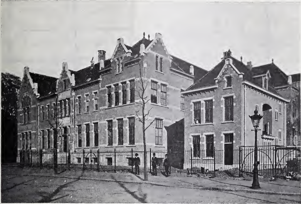
VOORGEVEL. — ONTLEEDKUNDIG LABORATORIUM EN CONCIERGE-WONING.
