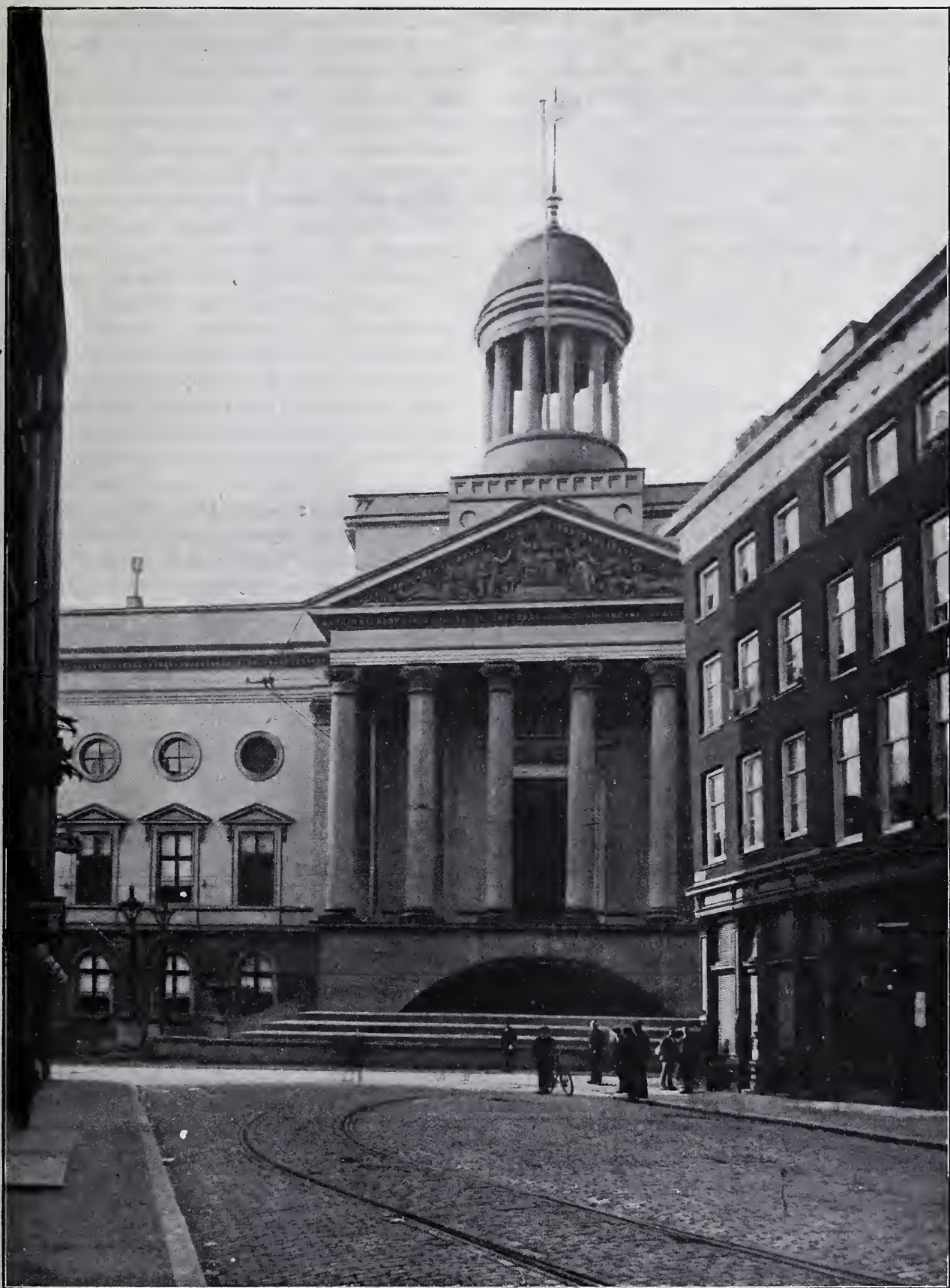
STADHUIS TE ROTTERDAM. (Gevel a. d. Kaasmarkt, gezien vanaf de Gedempte Botersloot.)
