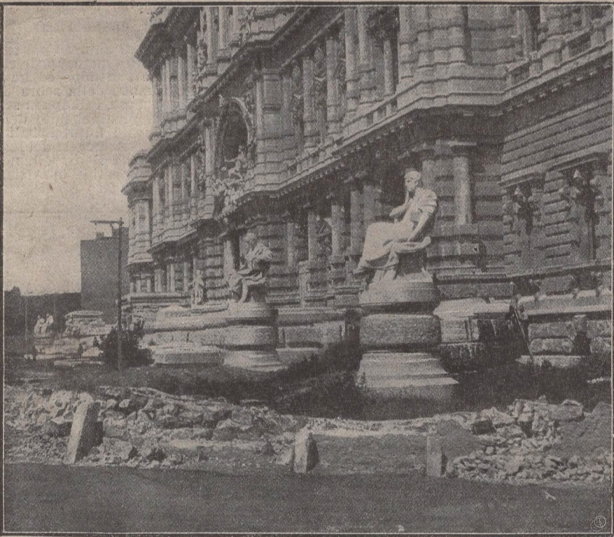
La scalea di accesso al nuovo palazzo di giustizia a Roma dopo la demolizione del muro. (Fot. Fontana)
