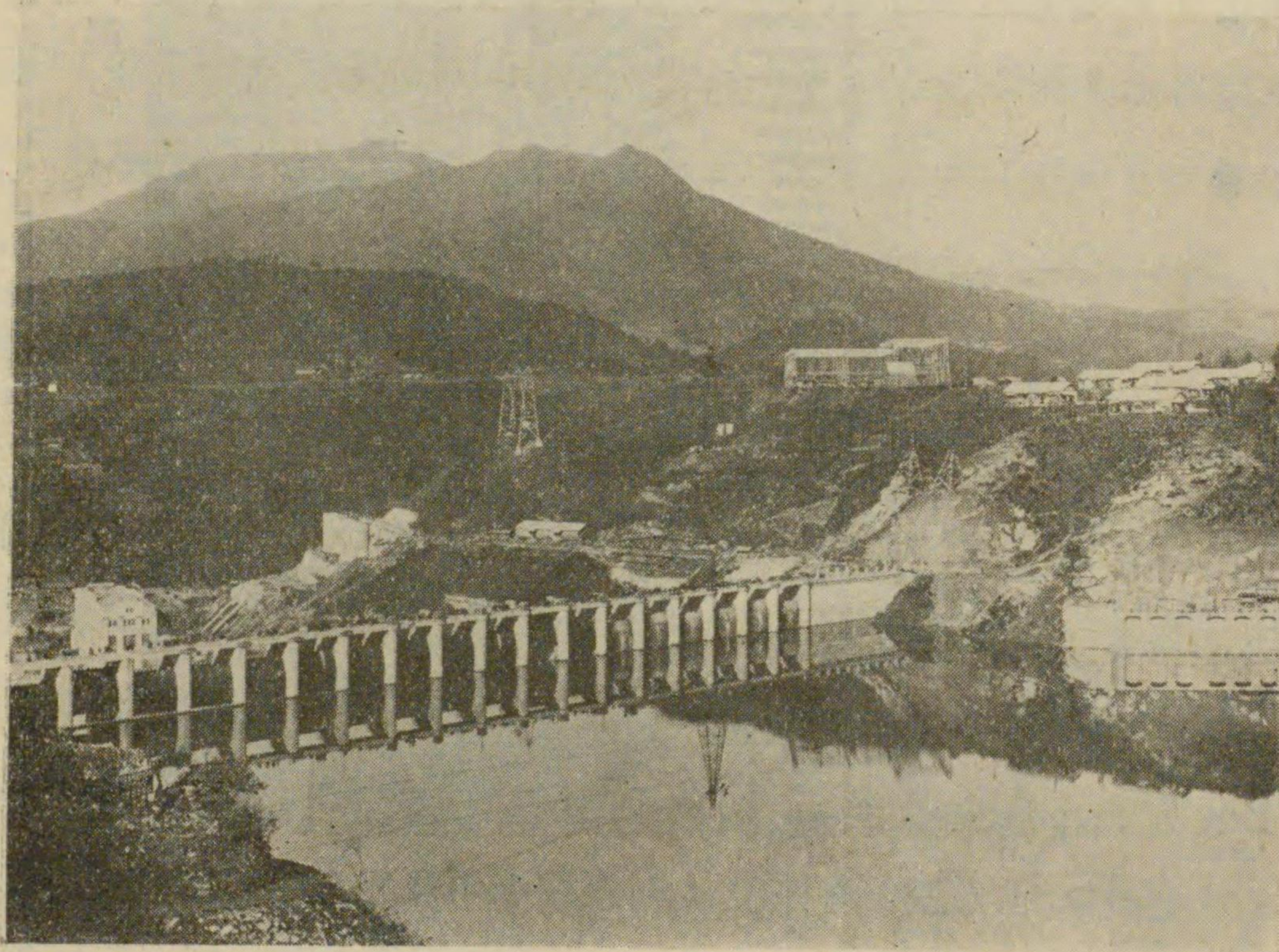
大同電力大井發電所
