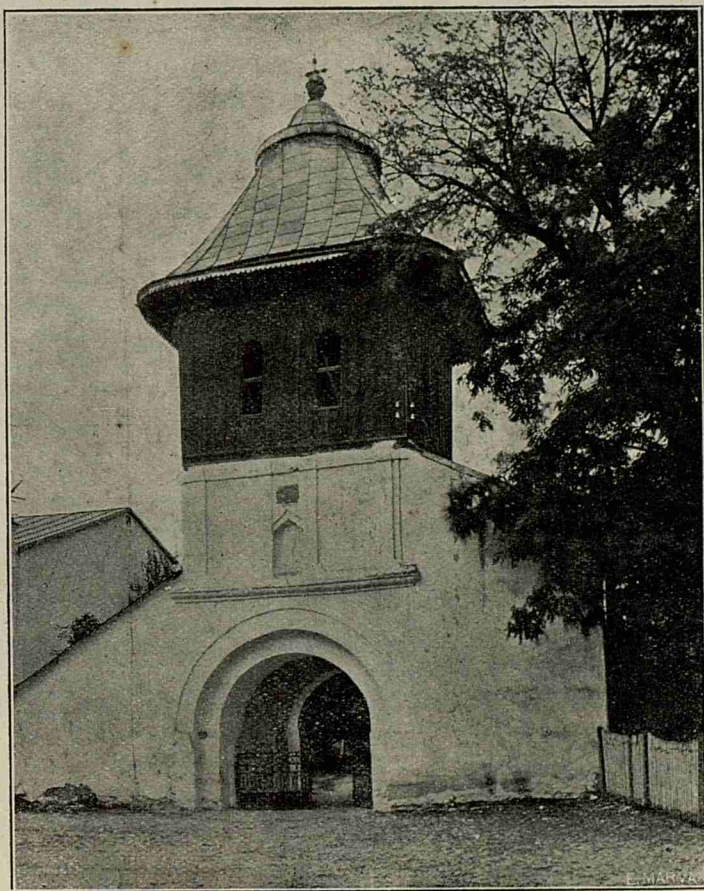
Fig. 1. Mănăstirea din Vălenii-de-Munte.
