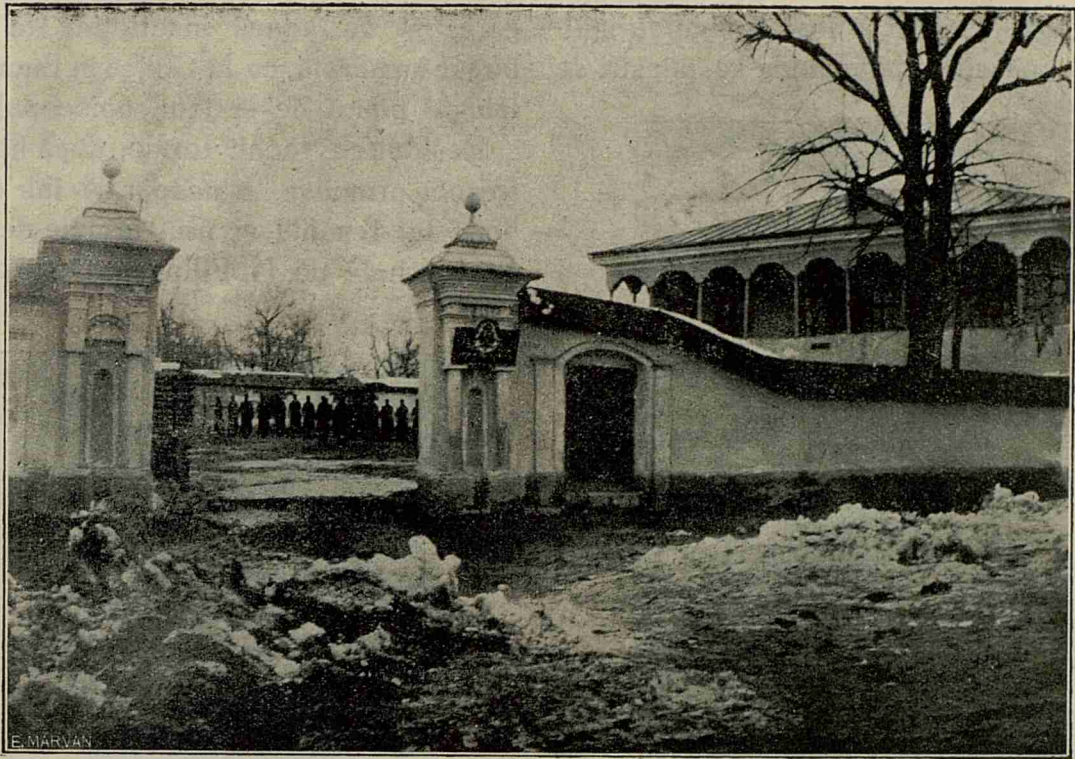
Fig. 10. Casa lui Mârzea din Vălenii-de-Munte.
