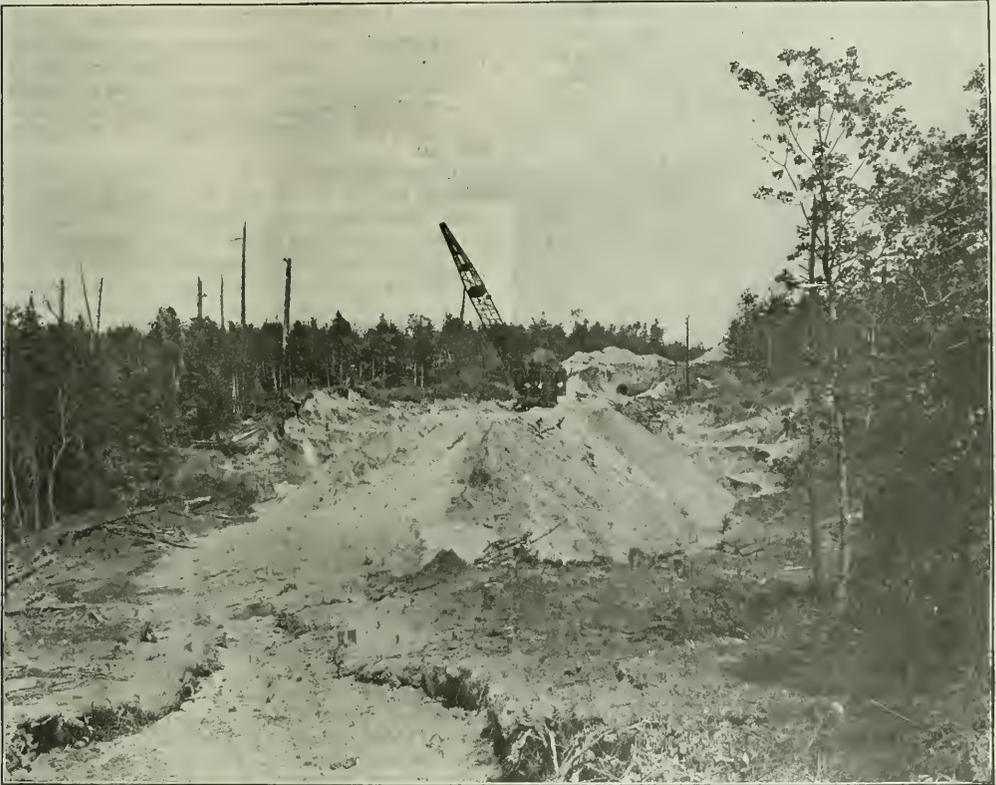
MAKING THE FILL FOR THE PIPE LINE ON THE DEAD RIVER POWER PROJECT
