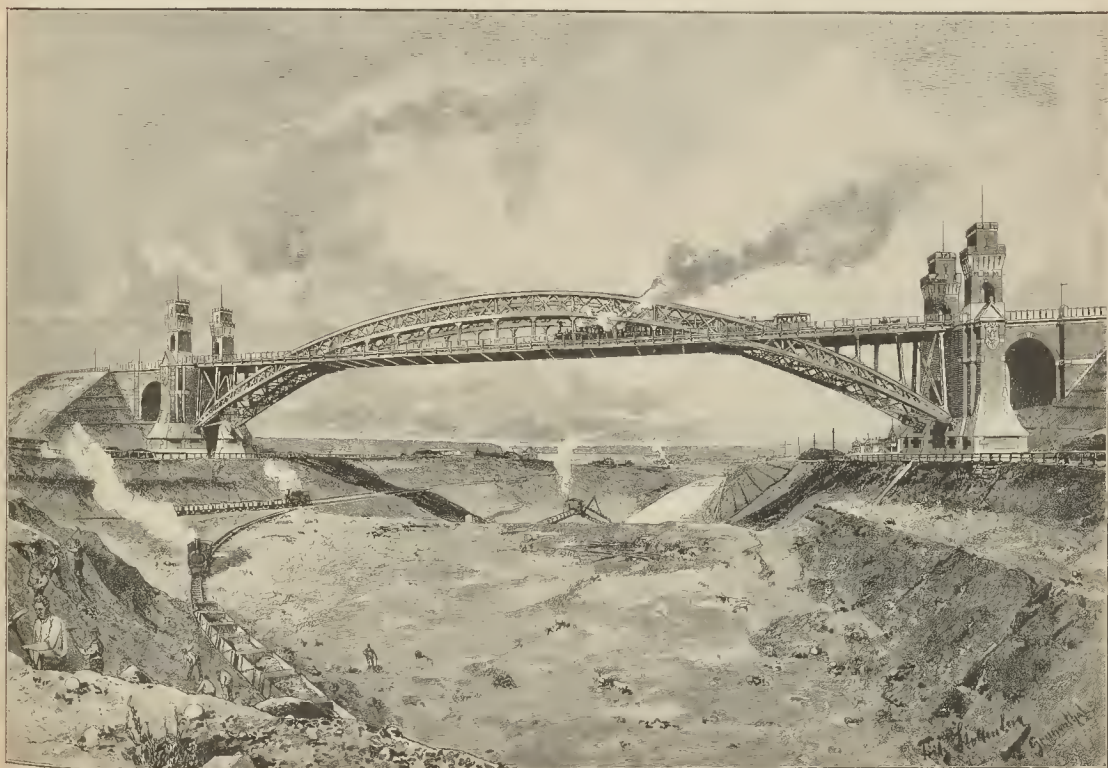
Construcción del canal de Kiel. El puente de Grunenthal, dibujo del natural de Federico Stoltenberg
