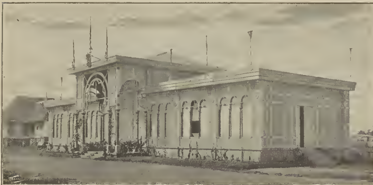
EXPOSICIÓN REGIONAL DE FILIPINAS. — PABELLÓN DE LA COMPAÑÍA GENERAL DE TABACOS DE FILIPINAS (De fotografía de M. Arias Rodríguez, de Manila. — Prohibida su reproducción)
