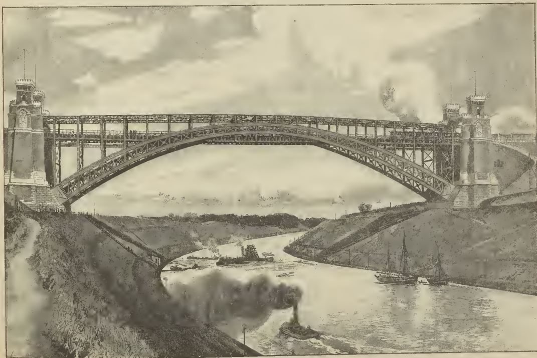
Canal del mar del Norte al Báltico. Puente de Levensau
