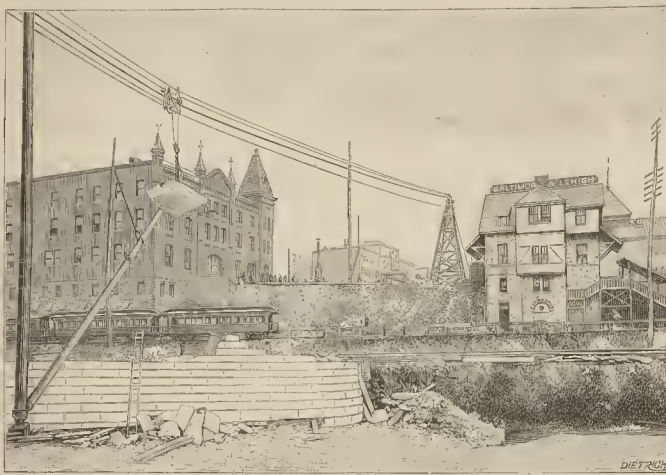
Fig. 1. - Construcción de un arco de piedra por medio de transporte aéreo por encima de dos vías férreas en Baltimore
