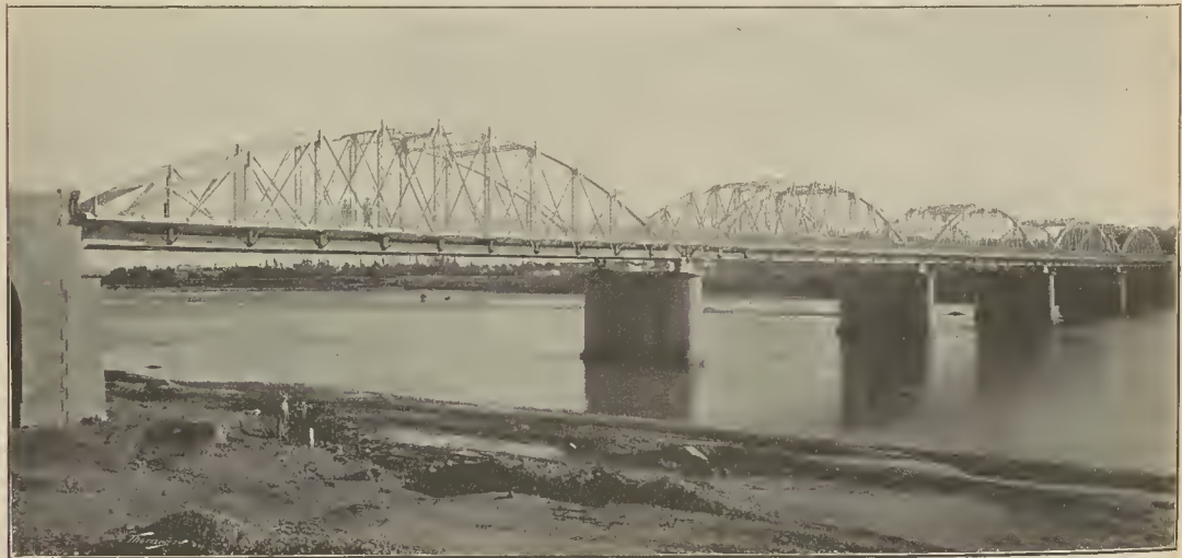
NUEVO PUENTE DE HIERRO SOBRE EL EBRO, CONSTRUÍDO POR LA MAQUINISTA TERRESTRE Y MARÍTIMA, solemnemente inaugurado en Zaragoza el 18 de octubre último (de fotografía)
