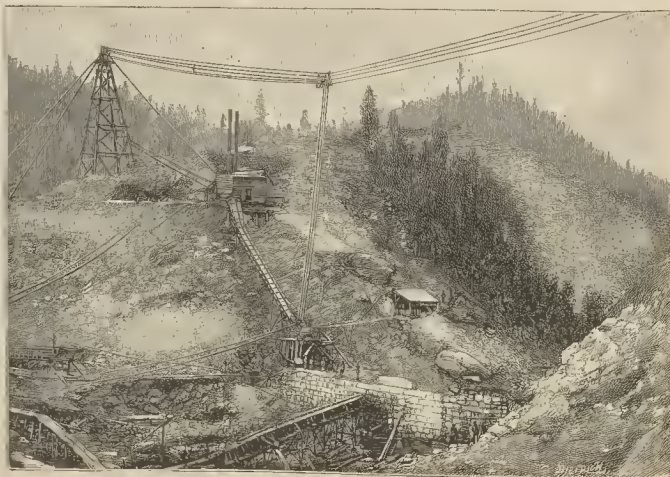
Fig. 3. - Construcción del dique del arroyo Basin, cerca de Butte (Montana)
