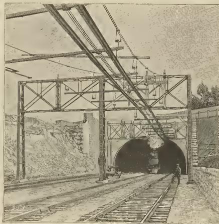
Fig. 2. - Salida del túnel de Baltimore con los conductores aéreos de toma de corriente
