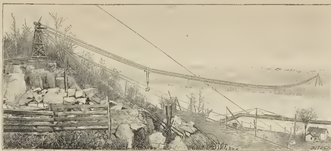
Fig. 4. — El transportador aéreo construyendo la esclusa de Point-Pleasant
