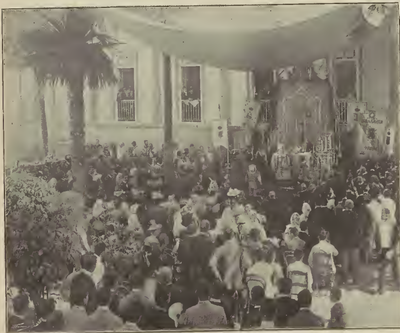
BENDICIÓN DE LAS OBRAS DE AMPLIACIÓN DE LA CASA DE SALUD DEL CENTRO GALLEGO DE LA HABANA (de fotografía remitida por los fotógrafos Sres. Otero y Colominas, de la Habana)
