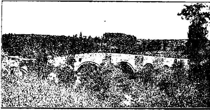
Puente de Sigüeiro sobre el Tambre
