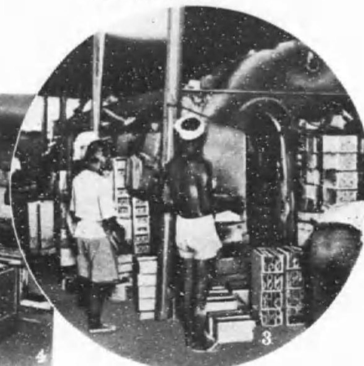
③ 一定の形につくつたものを蔭乾しにしてから焼く窯の外観
