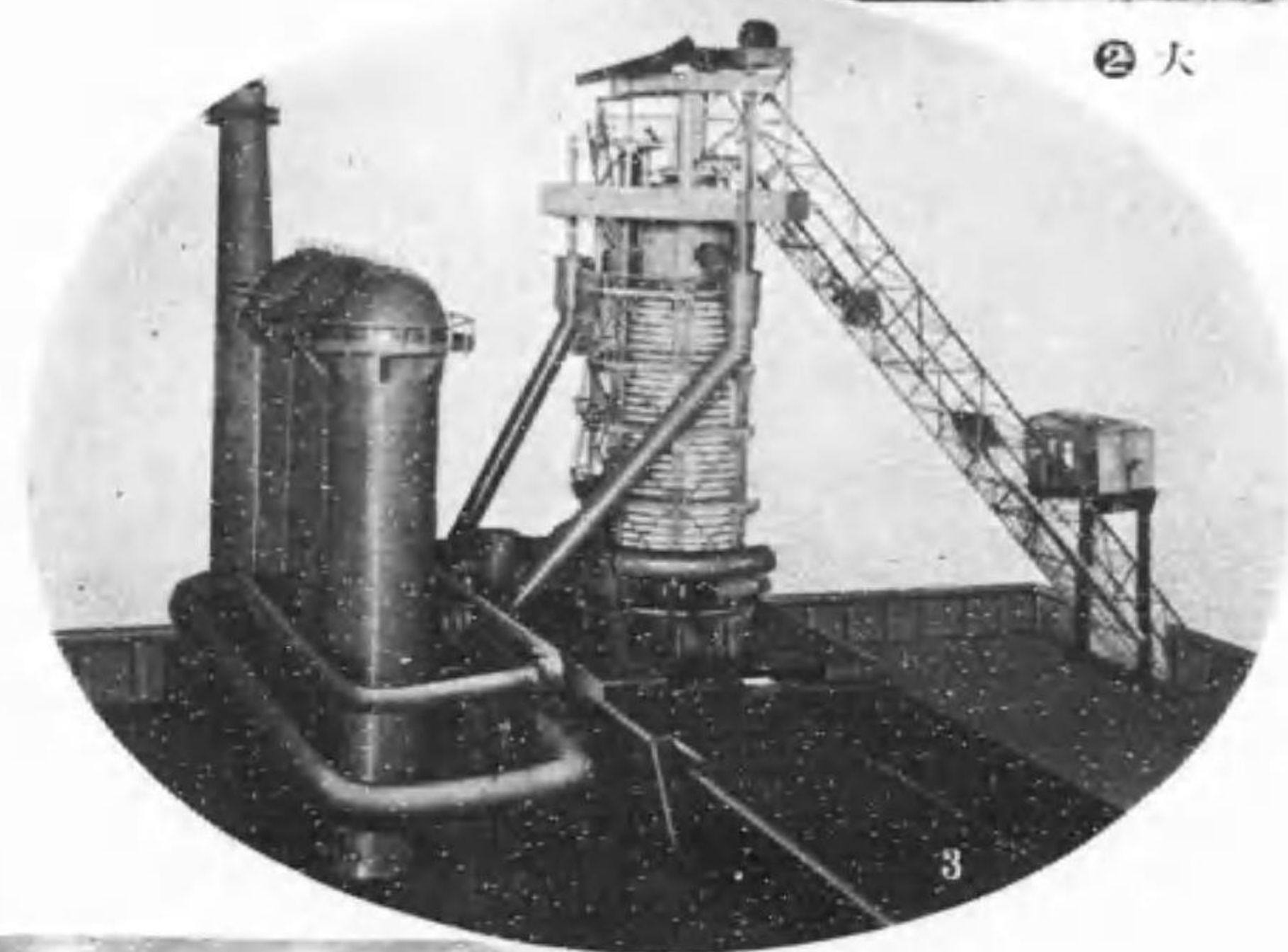
③ 熔鐵爐の外観
