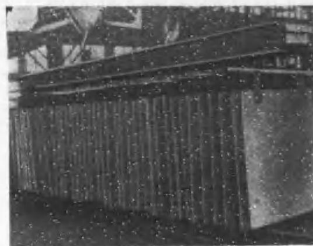
第102圖 銅の電解精錬で陰極に附着した純銅を引き上げたところ
