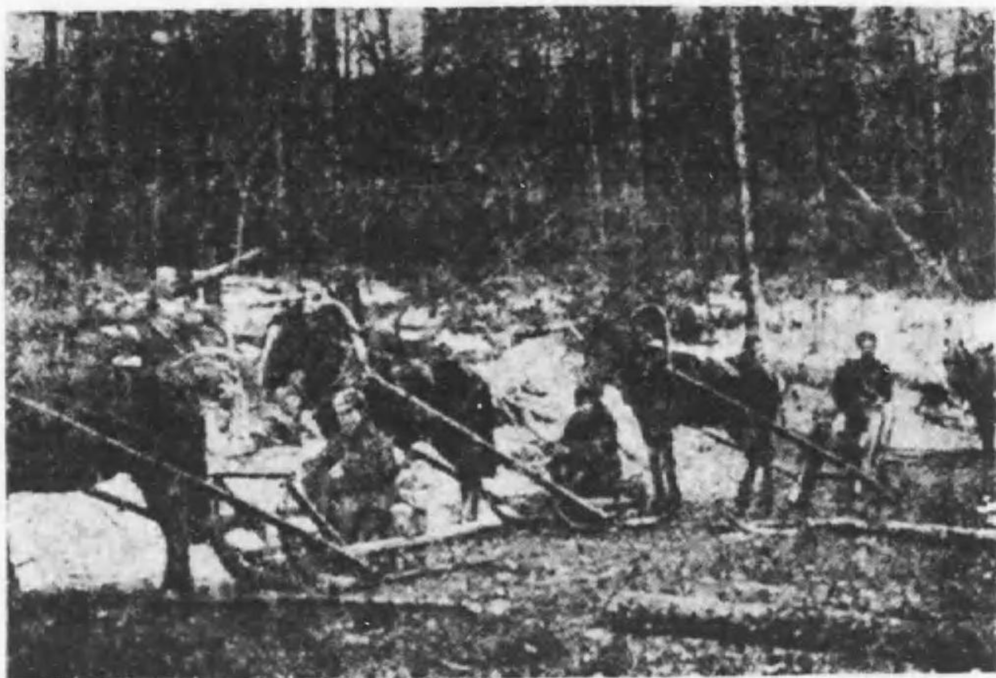
第12圖 農家用型橋及び林中運搬用橋
