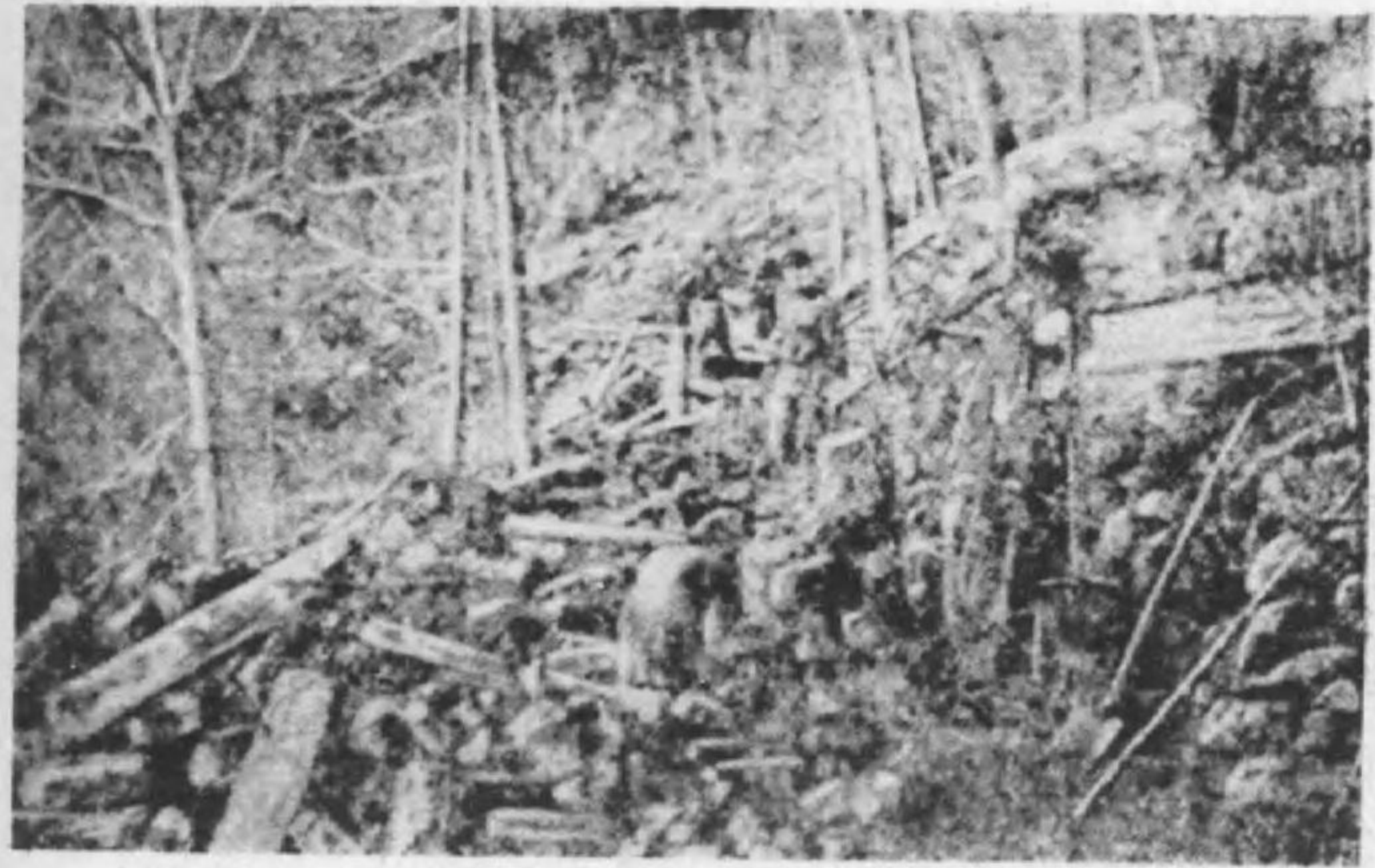
第13圖 石多く峻しき山の斜面に改良型橋による木材搬出路の鑿開
