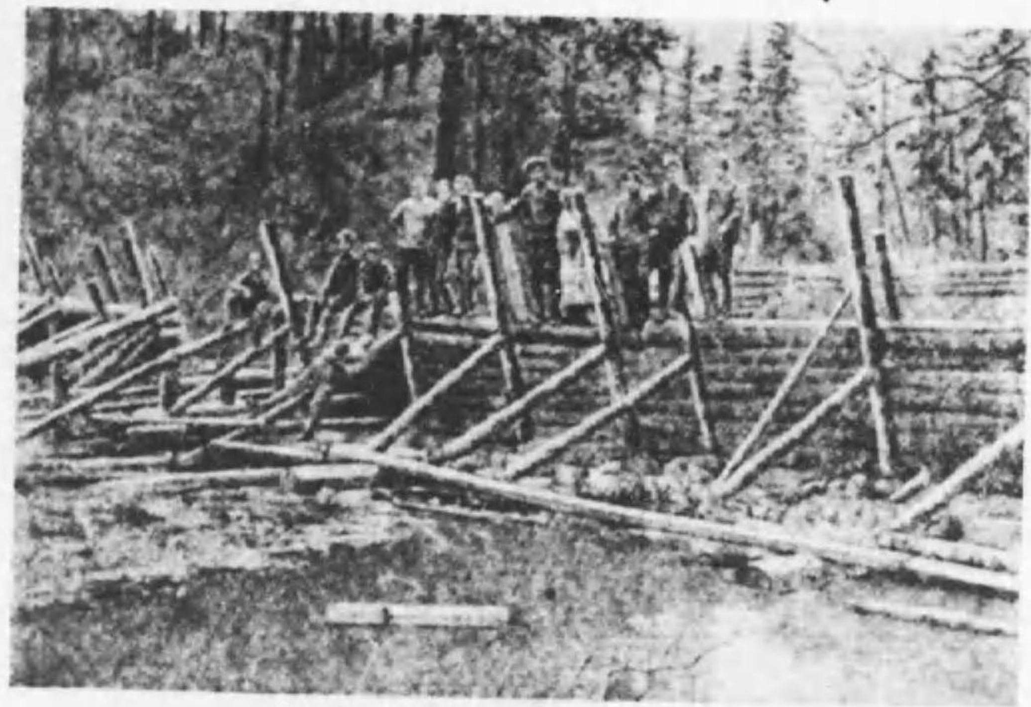
第20圖 水門の構築(南部沿海地方)
