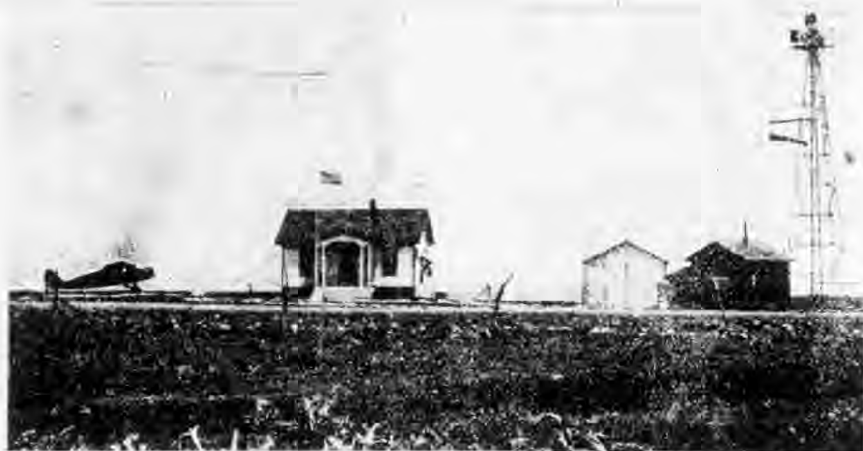
第一圖 夜間飛行機臨時降落站(甲)站長住宅(乙)汽 車間(丙)(電機場)(丁)廿四英寸交替燈標
