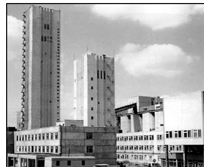
Копри шахти "Красноармійська-Західна № 1". Донбас.
