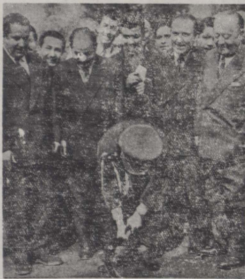
آقای سرتیب فرزنانگان تکفیل وزارت پست و تلگراف اولین کلنگ ساختمان جدید تلگراف تهران را با حضور روسای دوا بر مختلف آن وزارتخانه بر زمین میزند
