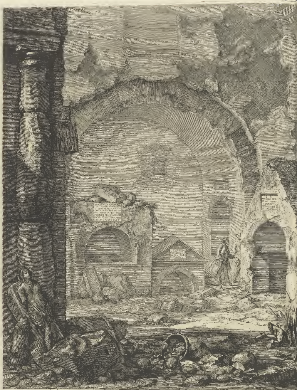
VEDUTA dell'Ingresso della CAMERA SEPOLCRALE di L. ARRUNZIO e della sua Famiglia. L'Anno 1736 nello scavar una vigna situata a mano sinistra prima d'uscire da Porta maggiore furono scoperte da Fr. B. lardi Assiutuale molte Camere sepolcrali, le quali sono state demolite a riserva della presente, e d'un'altra a questa vicina conservate ad istanza dell'Antiquaria Ficoroni. In questa per tanto contigua alle pareti, le quali sono d'opera reticolata, veggonsi incalcati molti sepolcri di varia grandezza e costruzione, per la quale, come ancora per la forma alterata de' caratteri delle Iscrizioni apposte a ciascun
