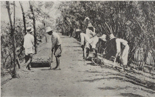
堤防修繕之一
