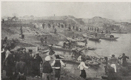
舢舨運土築堤情形
