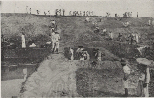
堤防修繕之二
