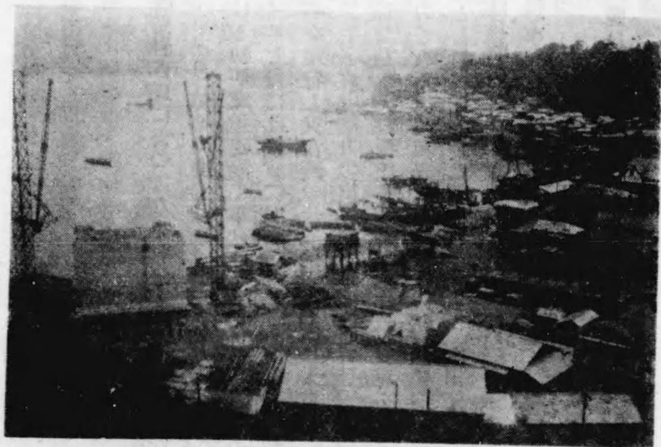
内務省宮古修築工事現場全景
