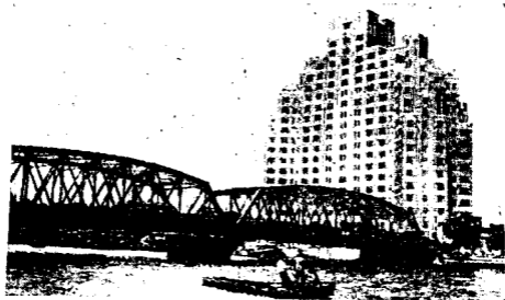
江 海 大 廈 與 外 白 渡 橋
