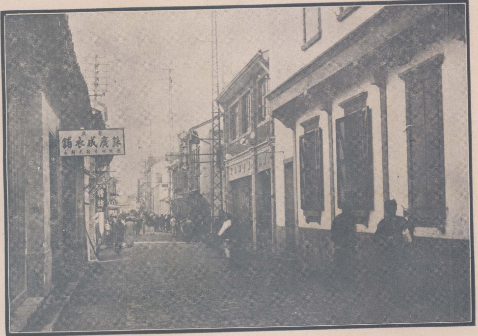
設新一道中錫爲元百千萬銀計竣部日二八工式日月年十，拓街下舊城路新。 。建之唯街城無。餘八七一費，告全十月，開正一六三二寬所塘三中爲生
