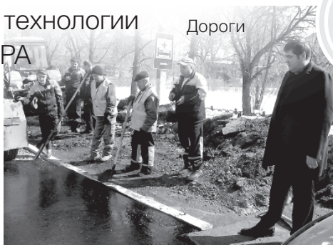
Денис Кошурников наблюдает за первым опытом ремонта дорог по новой технологии
