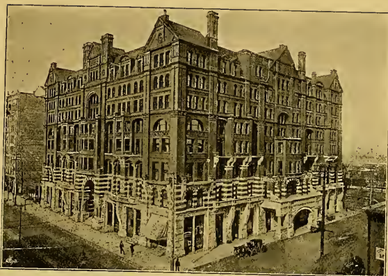
FIG. 127. WEST HOTEL, MINNEAPOLIS.
