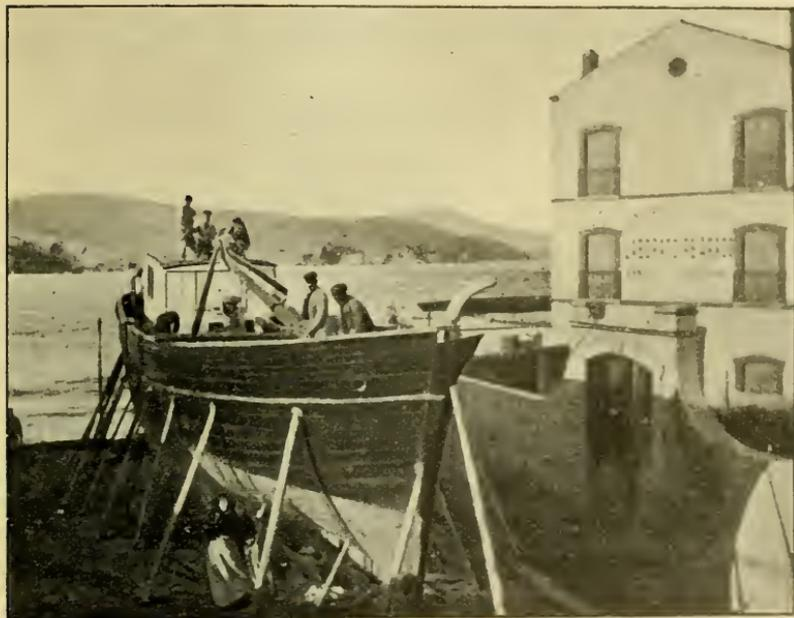
FIG. 2. — Mise en place du grand mât.
