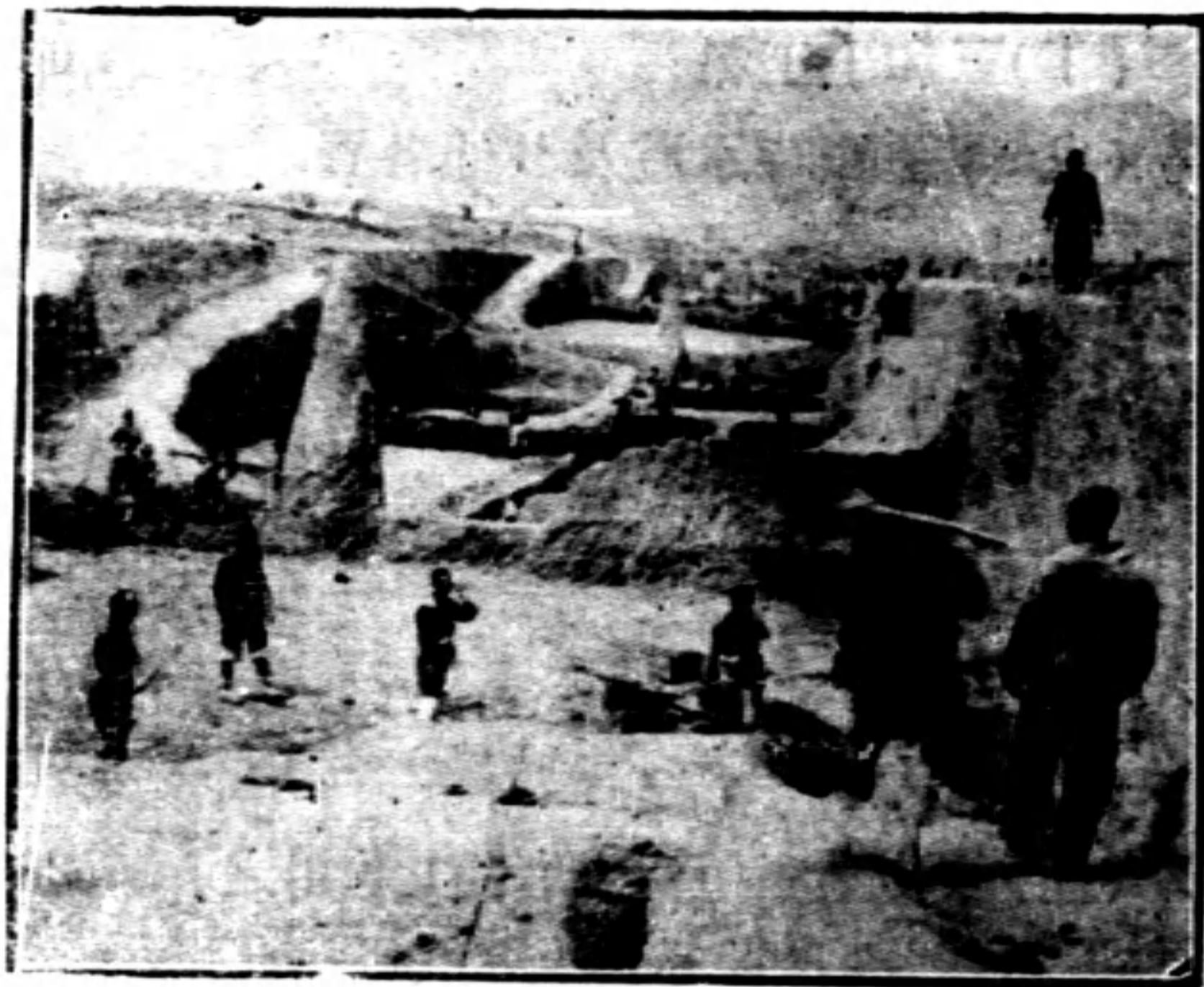
挖渠工作之進行
