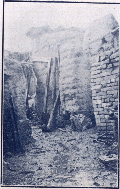
此係楊爲忠家大三口小四口住山東鄆城縣楊屯莊于民國十七年四月十八夜被匪攻入其父被鎗擊斃本年八月十一日勘災員與楊縣長邀同天主堂神父李動明在區災冒雨攝影之焚屋
