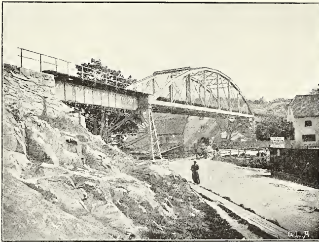
C. J. G. fot. 71. Saltsjöbanan, viadukt öfver Folkungagatan.
