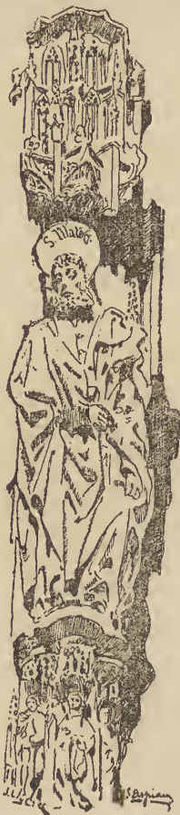
Détalle de la façade extérieure des Léonès
