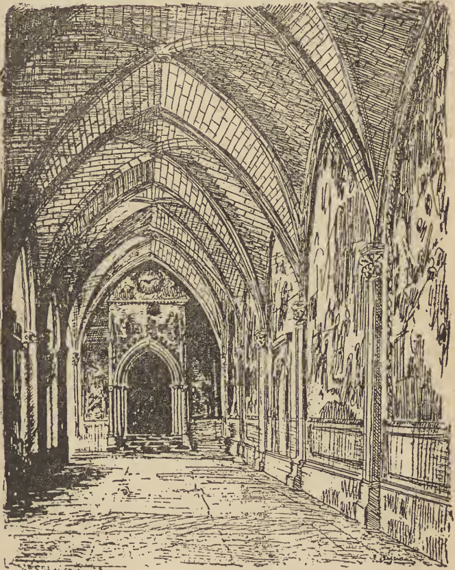
Cloître et façade de Saint Blaise
