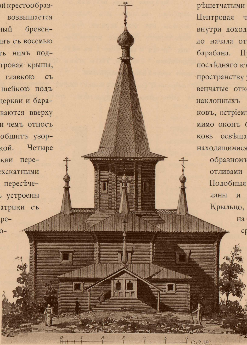
Западный фасадъ церкви.
