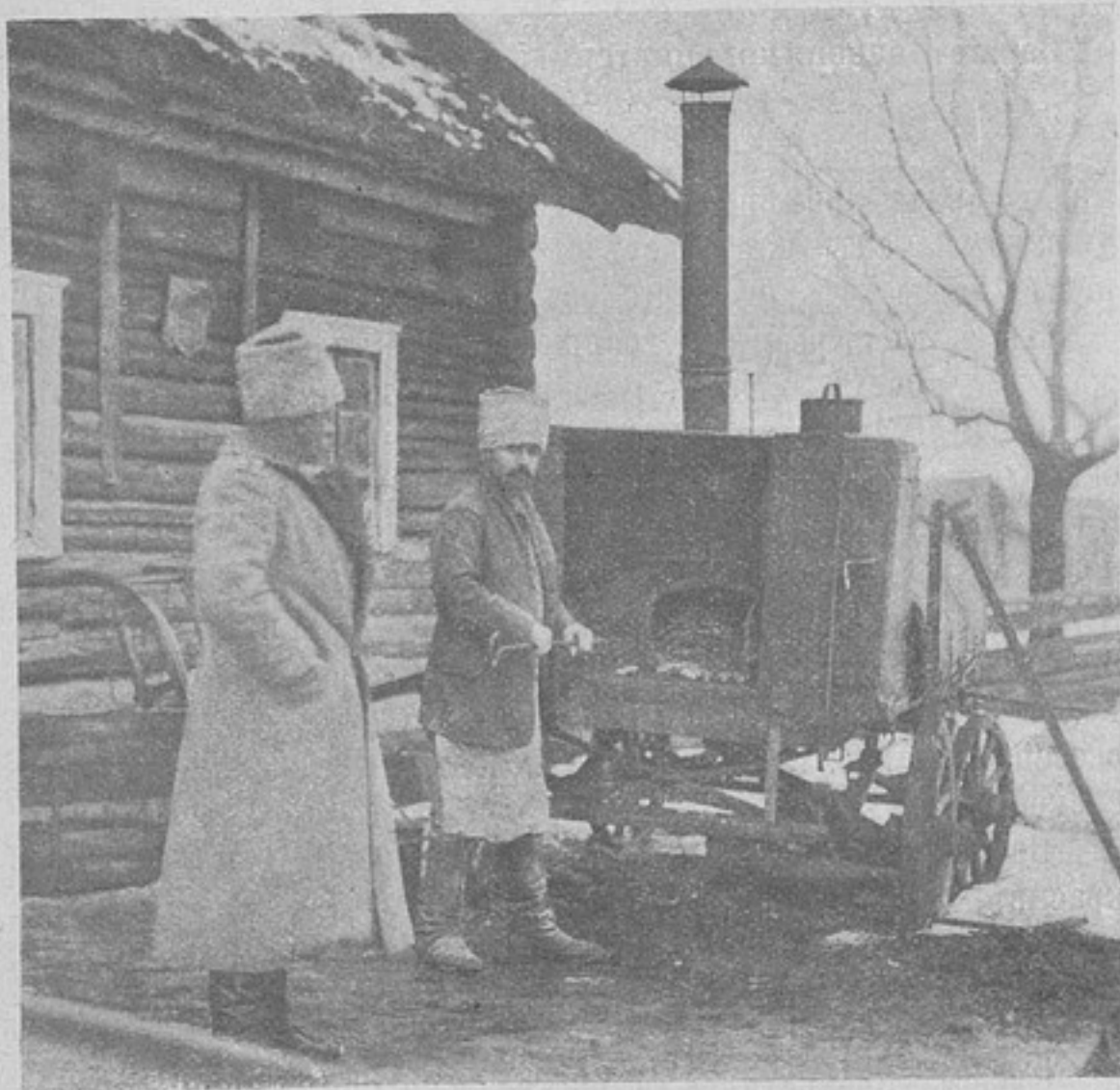
Походная хлѣбопекарная печь, устроенная изъ подручнаго матеріала капитаномъ Стрѣлковымъ, дающая по 18 пудовъ хлѣба въ сутки.
