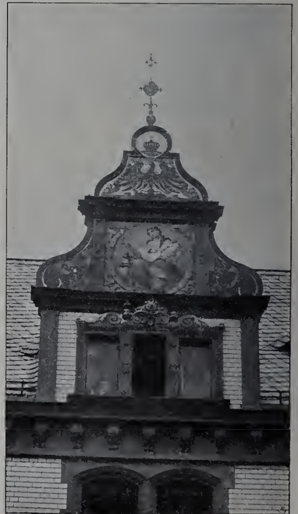
Dacherker am Geschäftshause der Firma P. Raddatz in Berlin, Leipzigerstraße 123. Der farbige Bildschmuck des Giebels ist nach dem Entwurfe der Architekten Rathenau & Hirschhorn in wetterbeständiger Frittmalerei von der Firma Villeroy & Boch (Merzig) aus- geführt worden. (s. auch S. 14.)
