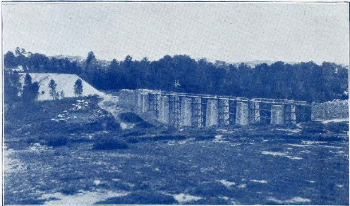
Viaducto en construcción en las proximidades de Carballino
